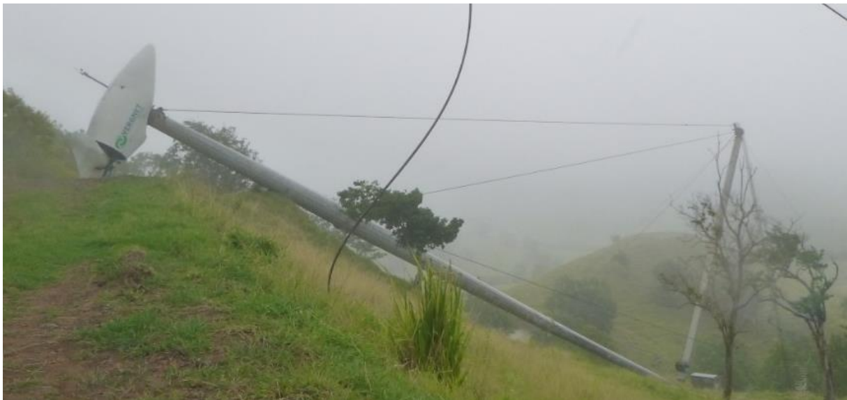
Photo 25 : Les éoliennes du Vauclin couchées pour maintenance.
