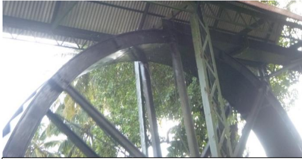
Photo 2 : Moulin à eau sur le site de la distillerie Depaz.
