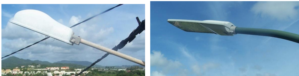
Photo 6 : Vieux luminaire (gauche) et nouveau luminaire LED (droite). Auteur : Service Technique de la commune de Rivière-Salée, n.d.
