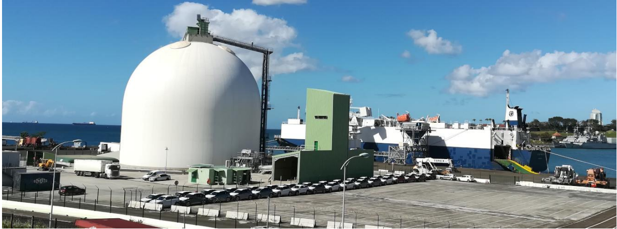
Photo 10 : Structure d'approvisionnement en combustible bois sur le port de Fort-de-France, à Pointe des Carrières.
