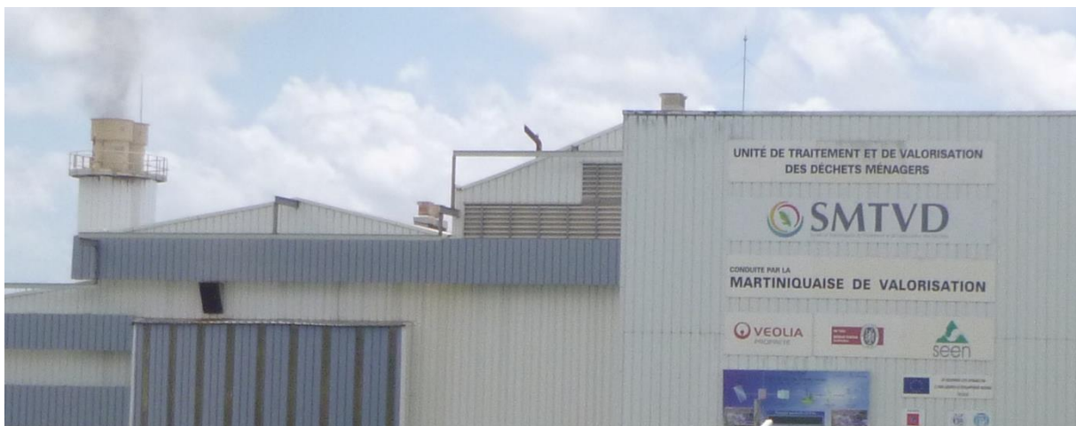
Photo 13 : L'usine d'incinération des ordures ménagères à Fort-de-France.
