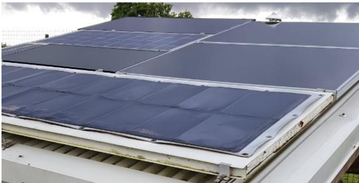
Photo 16 : Banc d'essai photovoltaïque suivi par l'AME sur le site de Saint-Pierre. Auteur : Blec, 2017.
