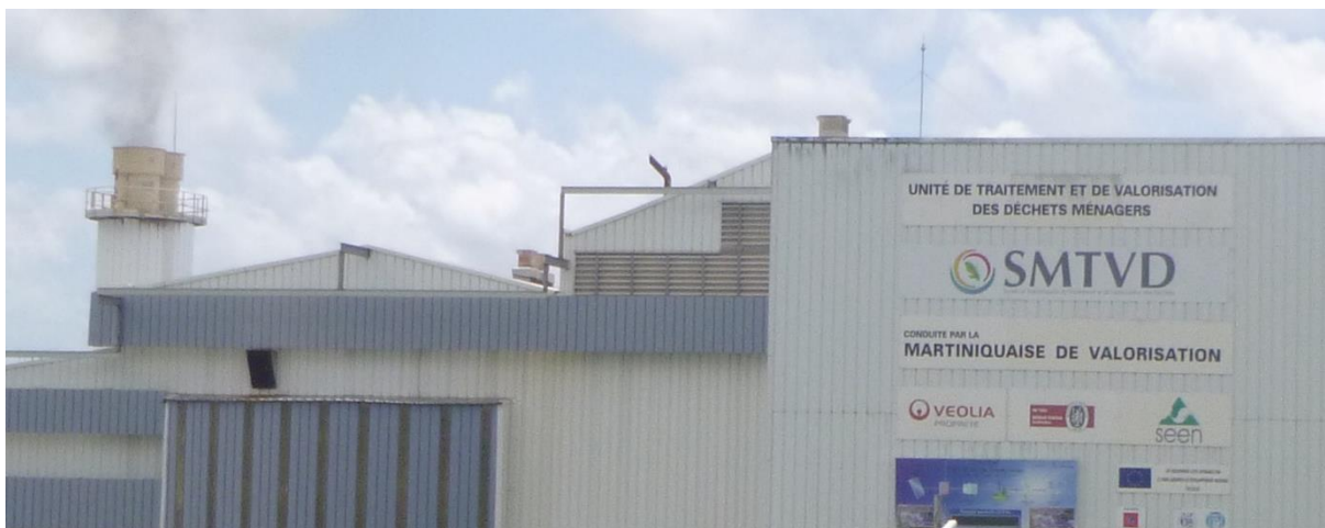
Photo 13 : L'usine d'incinération des ordures ménagères à Fort-de-France.
