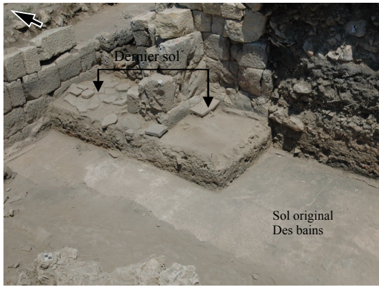
Fig. 62: frigidarium, coin nord-est, reste du dallage en terre cuite et dépôts stratigraphiques sur le sol original (archives de Patara 2006)
