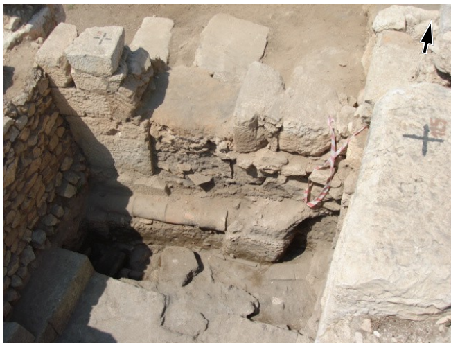
Fig. 82: façade Nord, entrée comblé menant au caldari-um .
