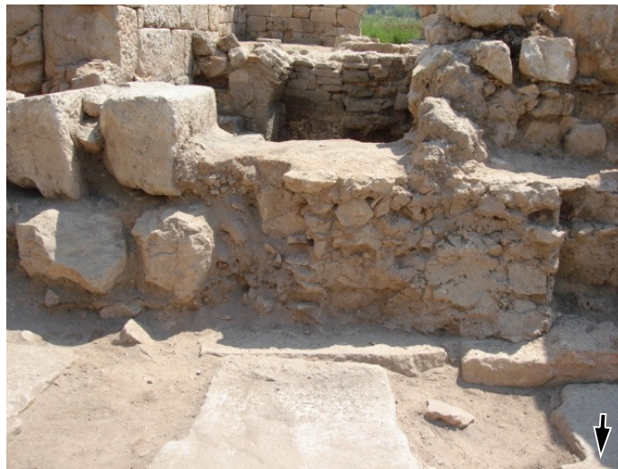
Fig. 81: façade Nord, sondages 12b,d /07
