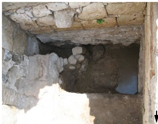
Fig. 99: façade sud, sondage 1/08
