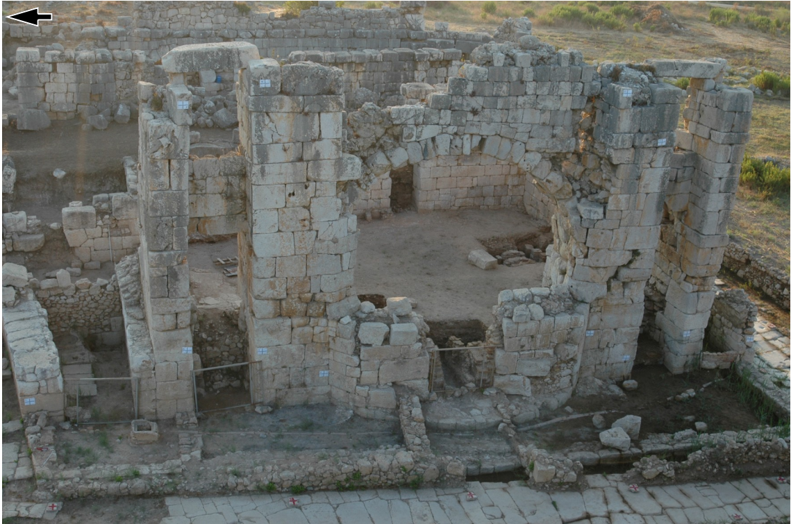
Fig. 34 : façade ouest des bains (archives de Patara 2005).
