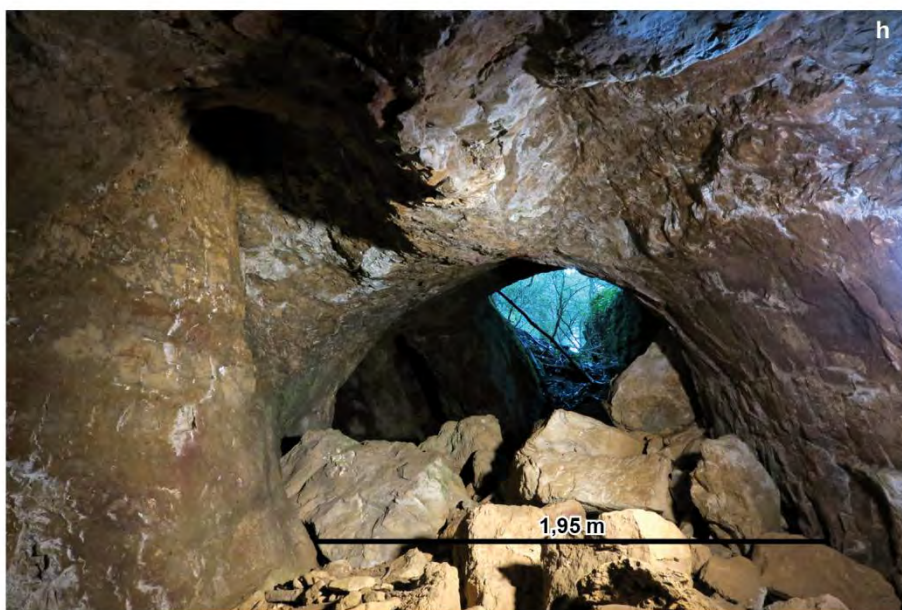
h. Chantier ouvert au feu constitué d'un volume principal unique surmonté de deux surcreusements correspondants à l'exploitation de filons verticaux.
