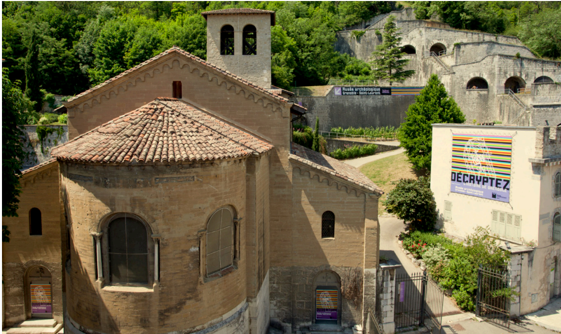
Fig. 30. Église de Saint-Laurent de Grenoble (d'après Wikimedia Commons)
