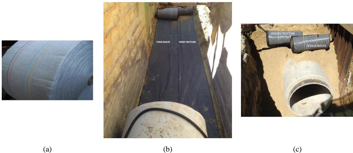
**Figure 4. 12 : Capteur géotextile posé sur le site : (a) bande de géotextile portant les câbles optiques ; (b) 2 bandes capteurs posées sous la conduite, différenciées par les notations « Fond Route », FR, et « Fond Trottoir », FT ; (c) 2 bandes capteurs posées au-dessus de la conduite, différenciées par les notations « Dessus Route », DR, et « Dessus Trottoir », DT**
