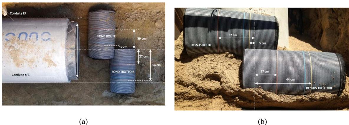
**Figure 4. 13 : Position mesurée des câbles optiques : (a) sous la conduite ; (b) au-dessus de la conduite**
