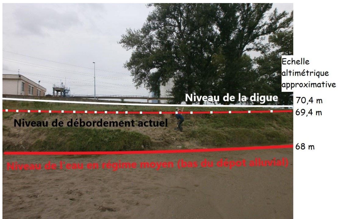
Figure VII.8. Le débit à plein bord probable sur le tronçon de la rivière Jiu entre la s.h. Podari et la tranchée (cliché : Moroșanu, 2017)
