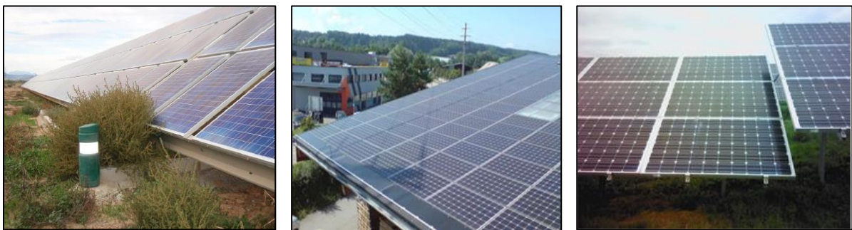
Fig. I. 6 : Quelques exemples d'ombrage permanents fréquentés dans les installations PV
