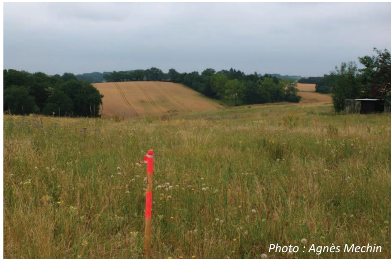
Figure 23 : Projet de gazoduc, avant le démarrage des travaux. Le piquetage délimitant la zone d'emprise du chantier a été réalisé.
