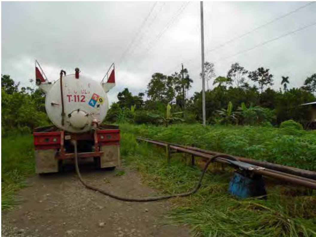
Image 5 : Gestion d'une fuite d'eau de formation à l'entrée d'une ferme (Communautés 9 de diciembre, Pacayacu, 2016)
