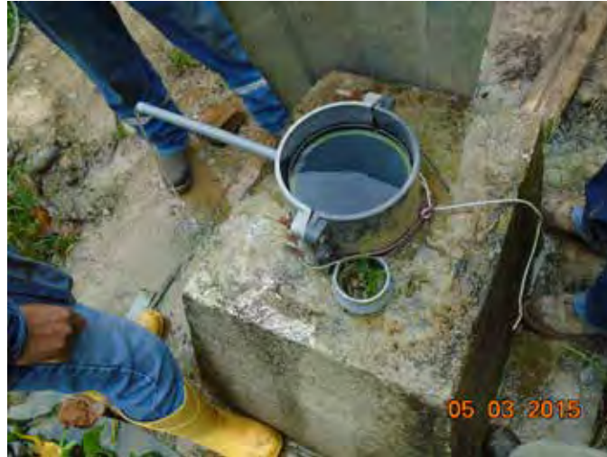
Image 23 : Résultats du forage pour la station d'eau potable de Dayuma, 2015 (doit alimenter 1500 personnes)
