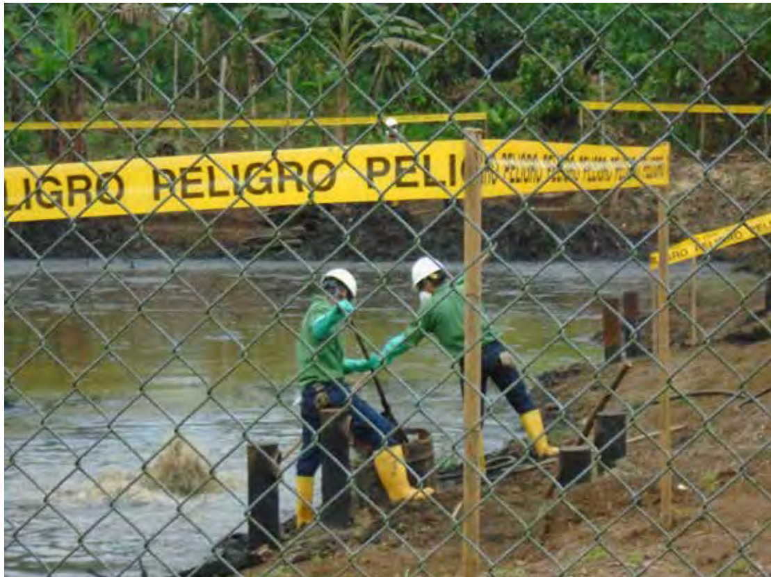
Image 17 : Piscine Pichincha 1 en cours de remédiation, Pacayacu, 2016
