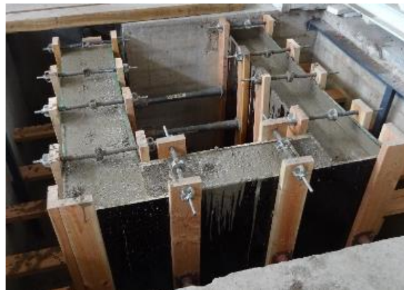
Figure 87. Coulage de la première couche constituant la structure en U
