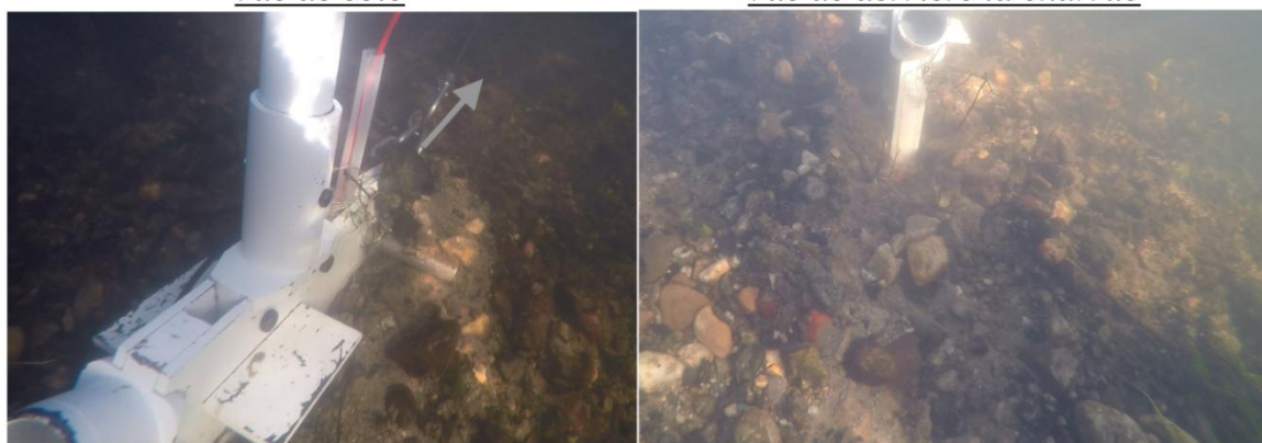
Figure 3-22. Photos montrant l'utilisation de la charrue pour installer les câbles de fibre optique. Le câble est introduit à l'intérieur de l'outil, qui est enfoncé dans les sédiments (vue de côté) puis tracté par un treuil. La progression de la charrue dans les sédiments conduit à l'enfouissement du câble au fur et à mesure en laissant peu de traces du passage (vue de derrière) [crédit photos : Alain Crave].
