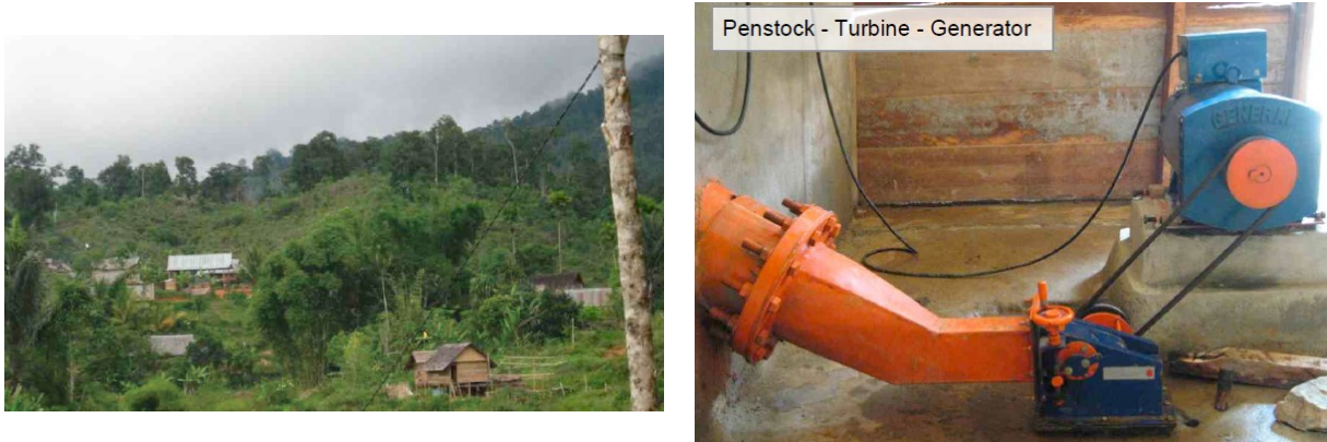
Fig 2.1 : Village Salulombe et centrale TP100 [2].
