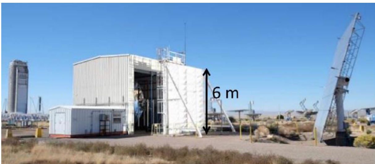
Figure II-5 : Installation de vieillissement au Sandia National Laboratory [54]
