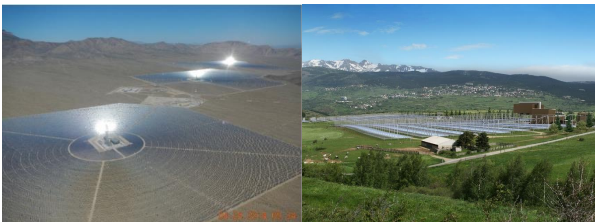
Figure I-6 : A gauche : centrale solaire à tours Ivanpah (Californie) – A droite : Centrale solaire à miroir de Fresnel eLLO (France)
