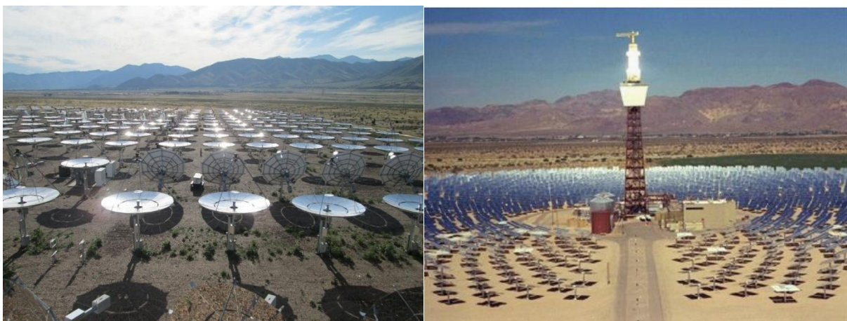
Figure I-11 : Centrales solaires à concentration ponctuelle. A gauche : centrale à récepteur parabolique Tooele Army Depot (Tooele, EU). A droite : centrale à tour Solar Two (Barstow, Californie)
