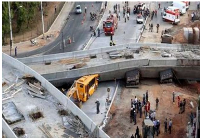
Défaillance, pont Belo horizonto (Brésil)
