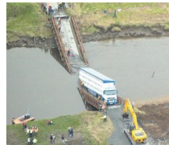
Défaillance, pont Ballignar (Inde)
