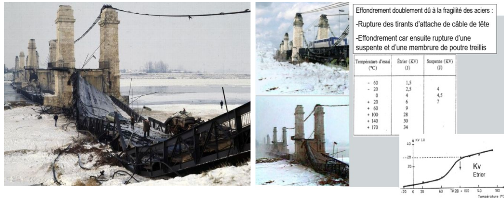
(a) état du pont Loire à la défaillance (16/06/1985) (b) détails de la défaillance sur pont Loire
