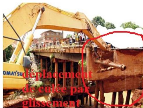
Figure 4.28 : Défaillance du pont Abakpa
