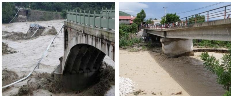
**Figure 3.14** : des défaillances causées par l'affouillement et détériorations
