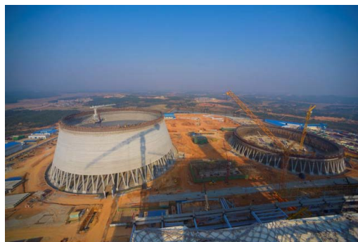
Chantier de Fuzhou
