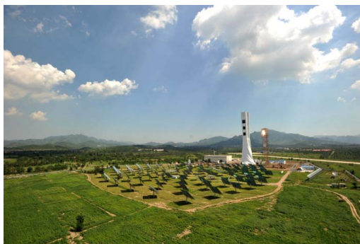
La tour du concentrateur de Badaling, entourée de ses 100 miroirs réfléchissants.
