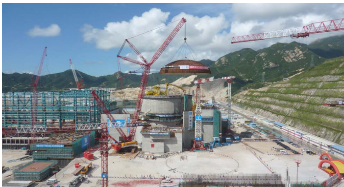
Pose du dôme de l'unité 2, 12 septembre 2012
