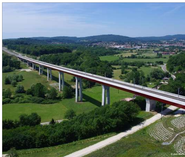
Figure 35 - Viaduc de la Lizaine (Lavigne et Chéron architectes)
