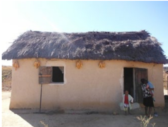
Cliché 15. Une habitation basse, avec toit en chaume et mur en torchis, district de Tsiroanomandidy (Réal : S. R, juillet 2017)
