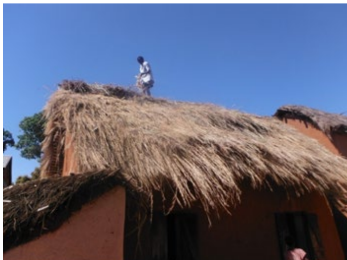
Cliché 7. Construction d'un toit de chaume, CR de Miadanarivo, district de Tsiroanomandidy (Réal : S. R, juillet 2017)
