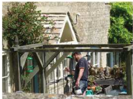
Un des employés du CT effectuant les opérations de maintenance pour les logements loués
