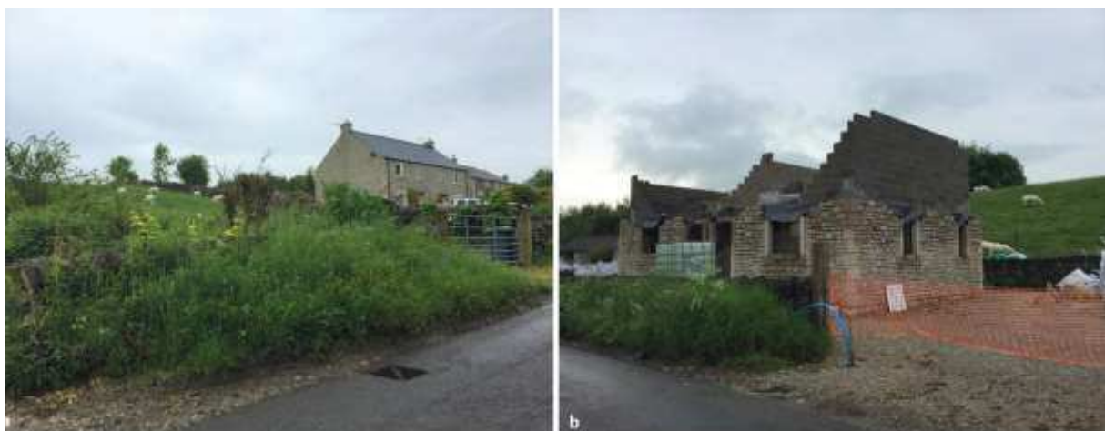
Photographie(s) 68 : À gauche, la limite du village. À droite, la nouvelle construction sur un ancien « greenfield ».
