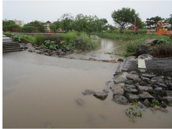
Figure A.8. 1 : Principe des bassins de rétention mis en œuvre dans le parc urbain du quartier de Ravine Blanche pour la gestion des eaux pluviales.
