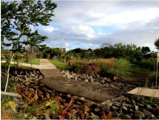
Figure A.8. 1 : Principe des bassins de rétention mis en œuvre dans le parc urbain du quartier de Ravine Blanche pour la gestion des eaux pluviales.
