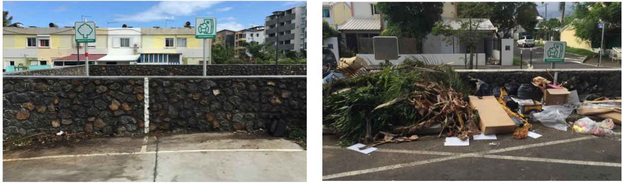
Figure A.7.3: Point d'apport volontaire (PAV) mis en place dans le cadre du programme de rénovation du quartier de la Ravine Blanche. Le système se présente sous forme de placettes en béton avec une partie délimitée pour les déchets verts (DV) à gauche et une partie pour les encombrants (ENC) à droite.
