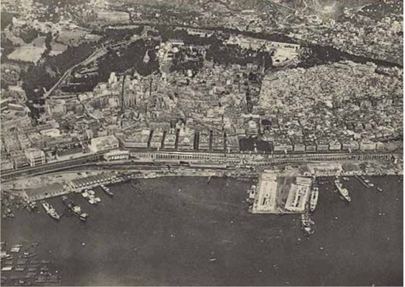
25 Les hauts d'Alger, "Le port et le centre commercial de la ville", Alger, 1935 ( Alger, ville neuve , 1935, p. 50).
