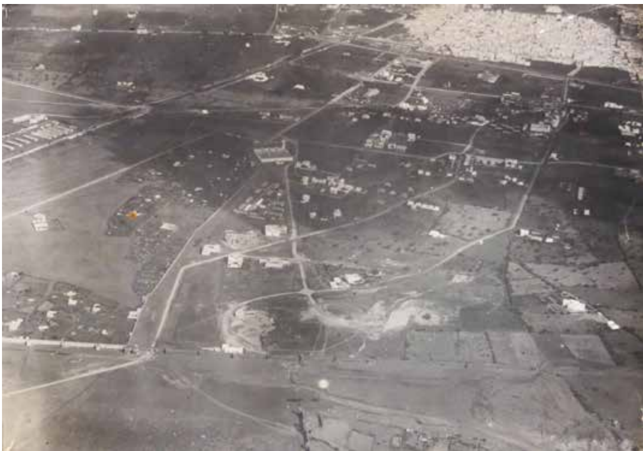
91 Henri Prost, Résidence générale et services administratifs, Rabat, Photographie aérienne du site et des bâtiments en chantier, 1917, Fonds Prost, loc. cit. , 343 AA 41/6.
