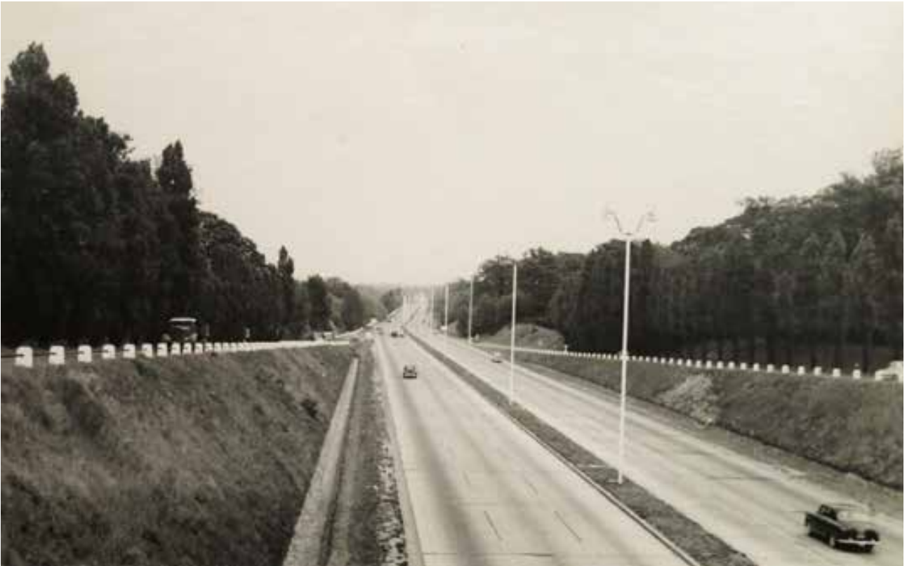
48 Henri Prost, Plan d'aménagement de la région parisienne, Photographie de l'autoroute de l'ouest, s. d., Fonds Prost, loc. cit. , 343 AA 60/4.
