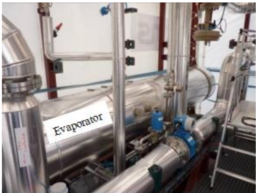
Figure 88. Photographie de l'évaporateur EVAP1 du PAT ETM (©Naval Energies)
