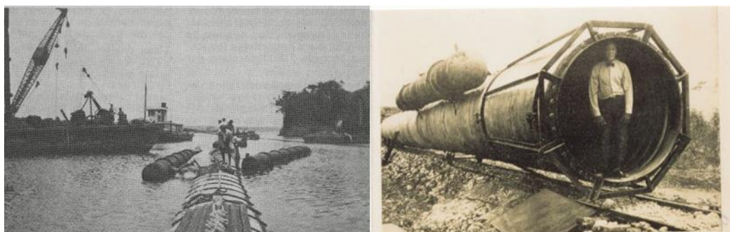
Figure 29. Photographies de l'installation des conduites d'eau froide en 1930 à Cuba (crédit ©Georges Claude, référence [7])
