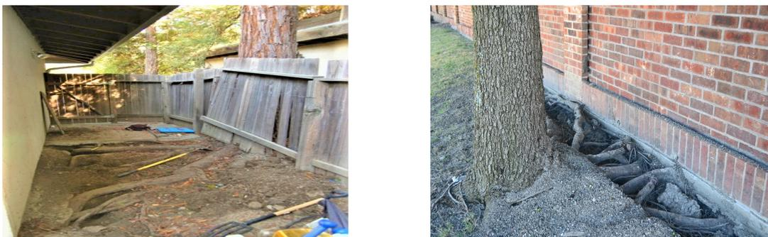
FIGURE 2.8 – Racines d'arbres se développant sous des bâtiments.
