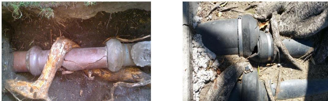
FIGURE 2.9 – Dommages causés par les racines aux canalisations.
