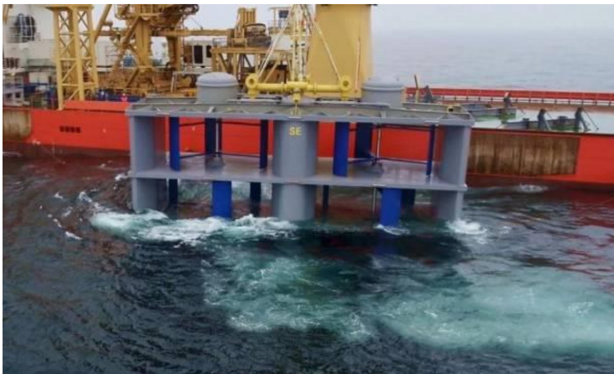
Figure 1.38. Image prise lors de l'installation de l'hydrolienne OCEANQUEST sur le site d'essai de Paimpol Bréhat [64].
