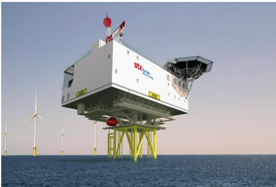
Figure 1.27. Sous-station électrique offshore [source : STX France].
