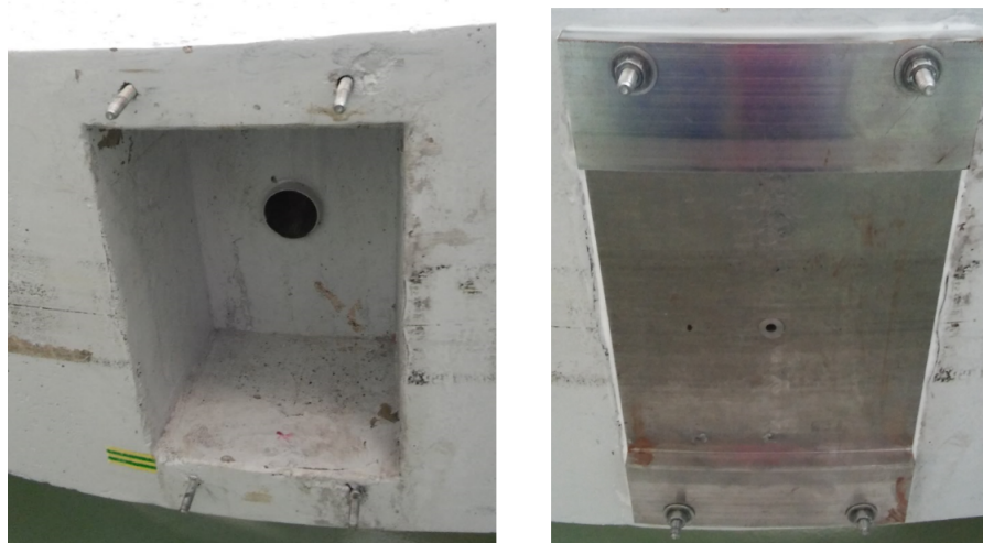
Figure 3.3 – Volume parallélépipédique (à gauche) recevant la plaque métallique intégrant la cavité cylindrique instrumentée d'un capteur de pression dynamique (à droite).
