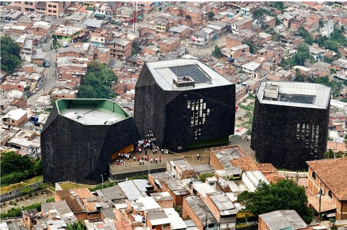
Figure 51 : Bibliothèque-parc España du PUI de la Zone Nord-Est, Medellín. Source : Google Image, 2018.
