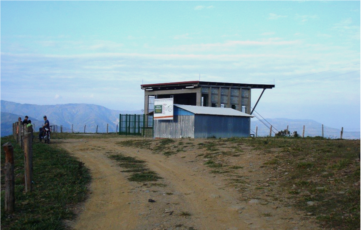
Figure 30 : Téléphérique de Yarumal, station El Llano, Antioquia (1). Source : Remontées mécaniques, 2013.
