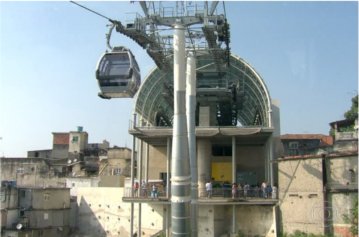
Figure 43 : Téléphérique du Morro da Providência, Rio de Janeiro. Source : Google Images, 2019.
