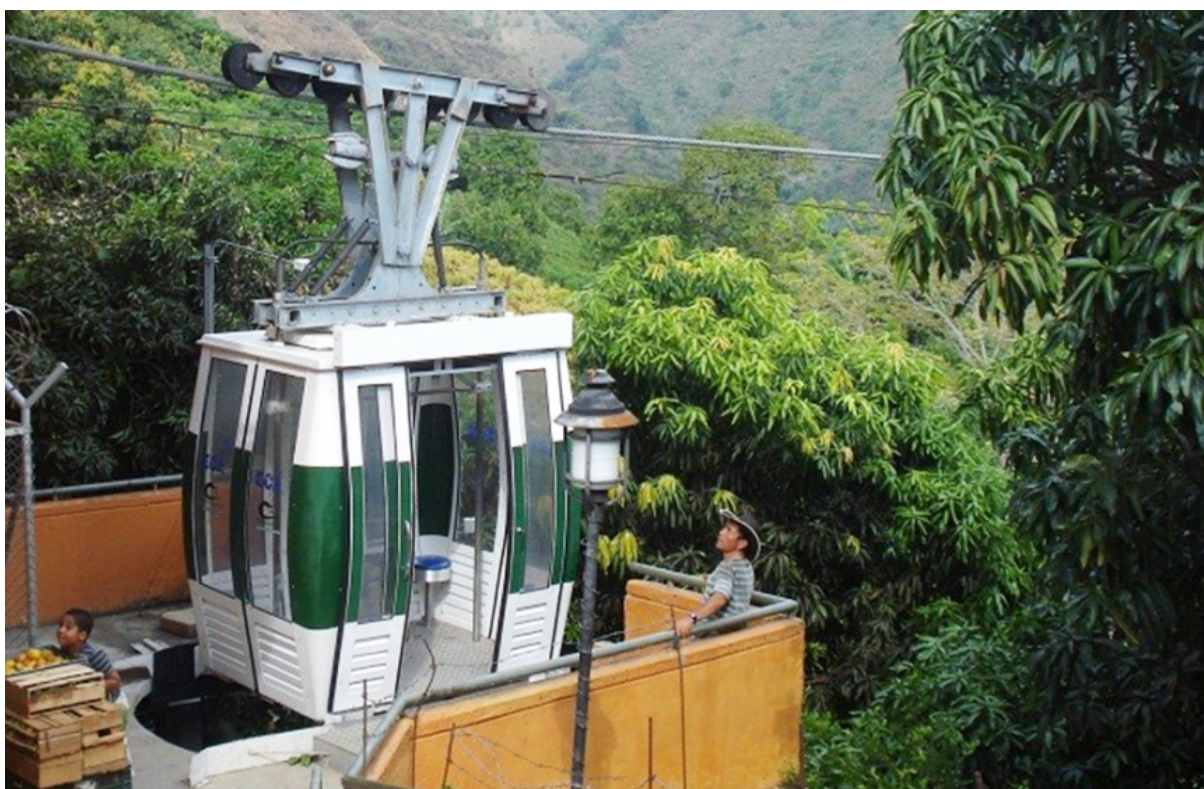
Figure 23 : Téléphérique de Sopetran, nouvelle cabine, Antioquia, 2003. Source : Remontées mécaniques, 2013 143 .
