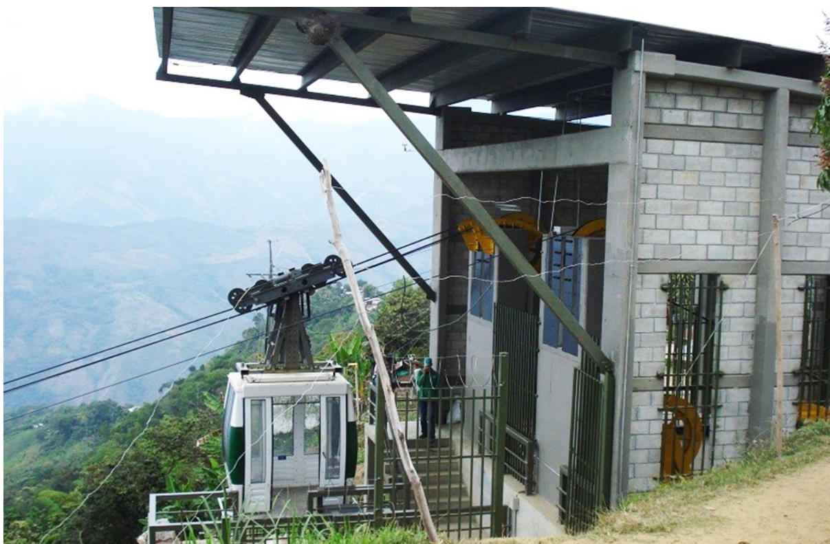
Figure 27 : Téléphérique de San Andres de Cuerquia, station La Cordillera, Antioquia. Source : Remontées mécaniques, 2016.
