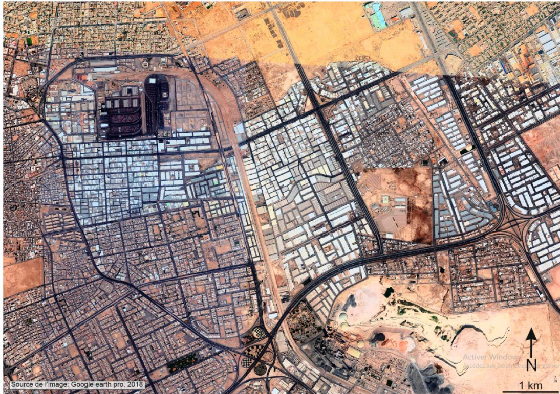
Photo 3: Ville industrielle Riyad
