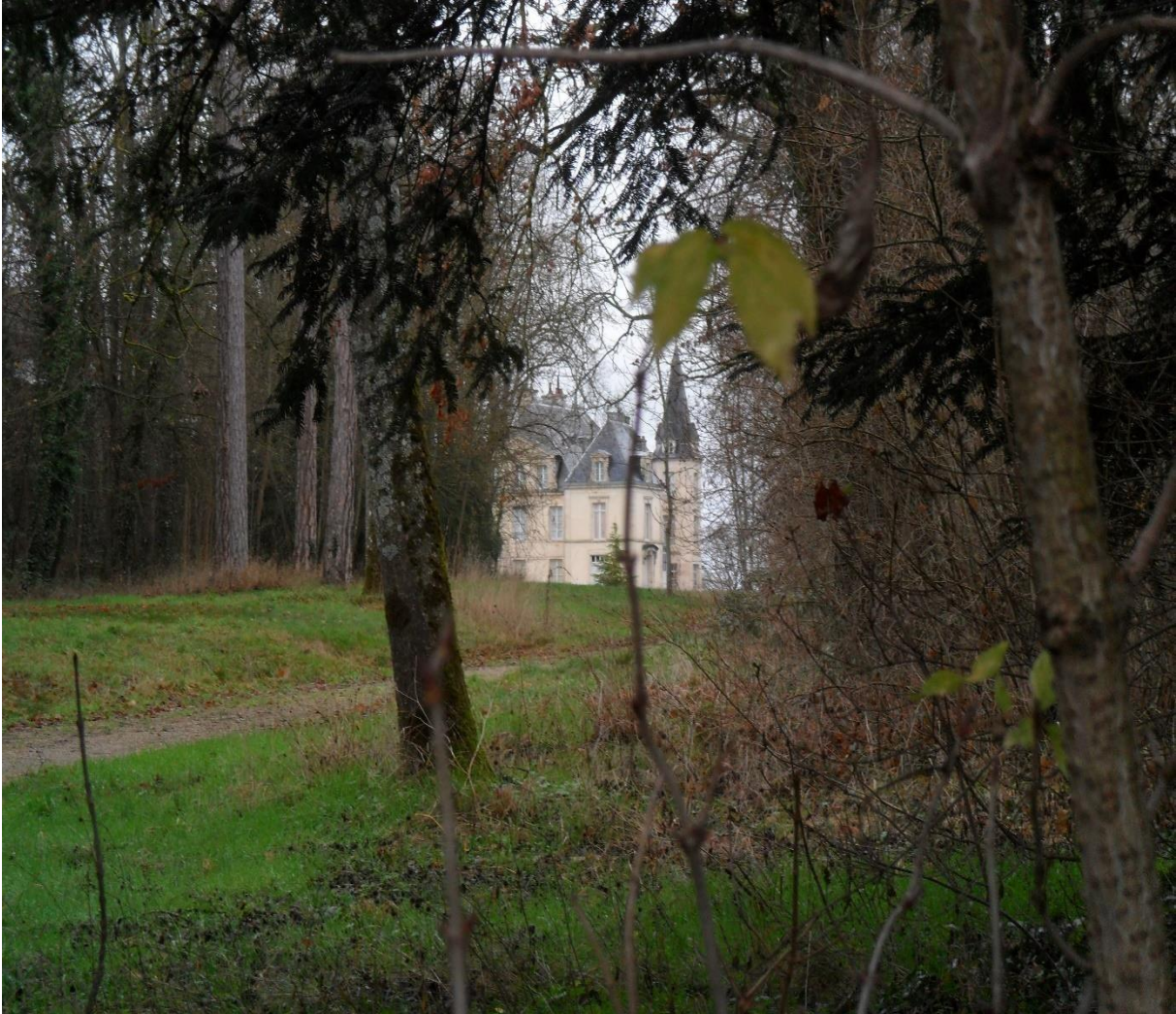
Vue partielle du château du maréchal Marmont Châtillon-sur-Seine (Photo prise par moi en janvier 2016)
