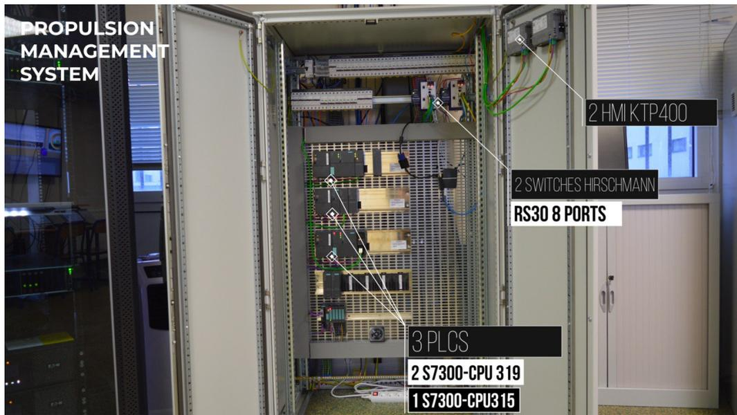
FIGURE IV.4 : Aperçu de la boucle mobilité (le capteur NIDS se situe en haut à droite de la baie) (source : [Chaire de cyberdéfense des systèmes navals](#), reproduite avec l'aimable autorisation de l'auteur).
