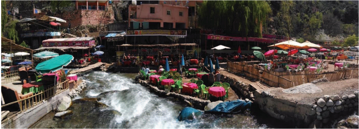
Figure 66: Empiètement des terrasses de restaurants sur le cours d'eau à Setti Fadma.
