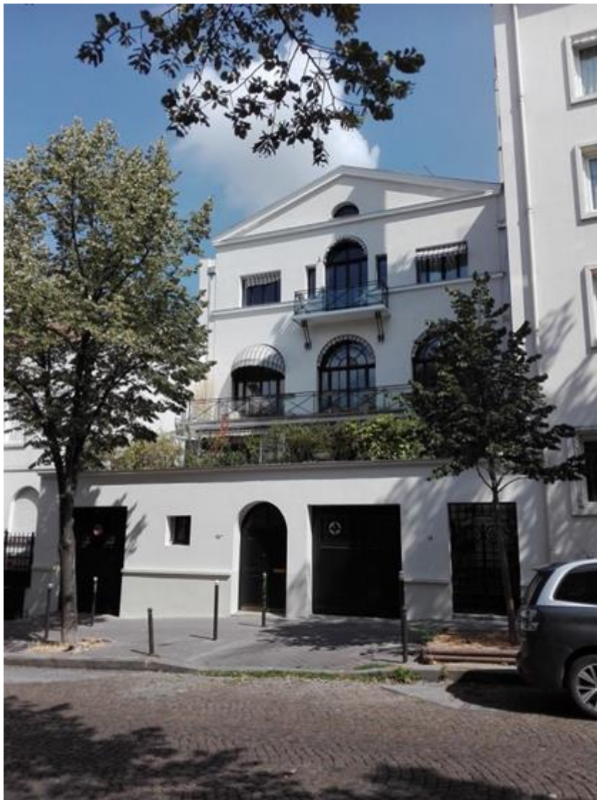
Illustration 2-3 La maison et l'atelier de Daragnès avenue Junot à Paris photographiés le 22/08/2018.
