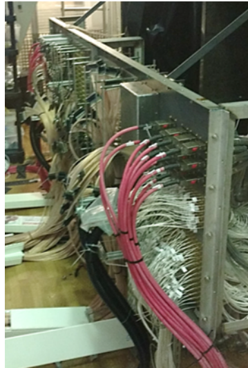
FIGURE 4.2 – Photographie d'un panneau d'étanchéité au niveau de la tente anti-radon permettant la continuité du câblage. Harnais rouges : haute tension ; câbles blancs : signaux ; câbles noirs : toron de fibres optiques ; câbles marrons : trajectographe.
