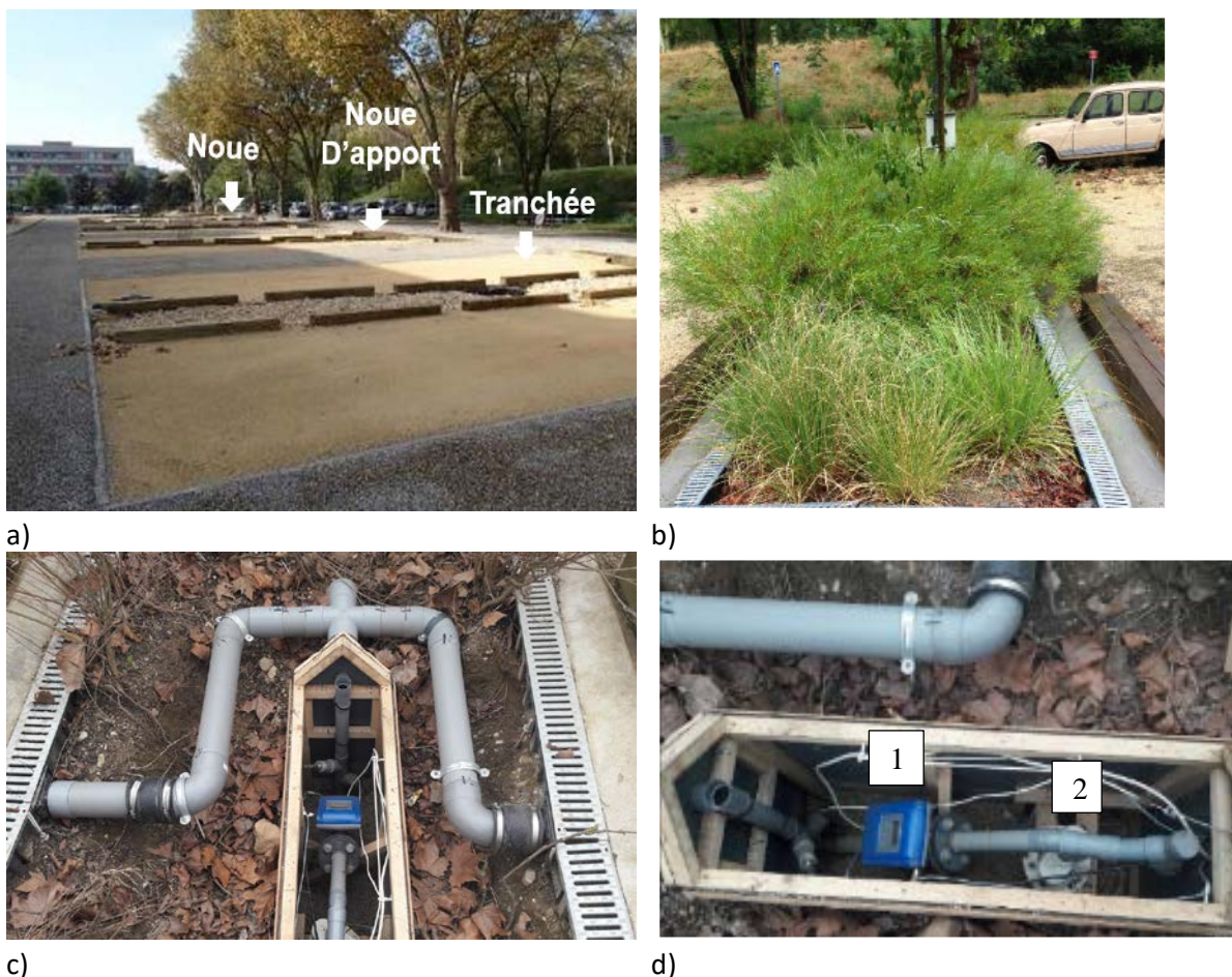
Figure 2.8 : Système de mesure permettant d'évaluer les débits et volumes d'eau en entrée des systèmes drainés par la noue et la tranchée. a) montre la localisation et la similitude du site avec les systèmes munis de la noue et de la tranchée, b) montre le site permettant d'estimer les apports avec installation à la périphérie des caniveaux collectant les flux avant entrée dans un ouvrage, c) et d) la connexion des caniveaux au système de mesure (double mesure 1/par auget basculant et 2/par mesure électromagnétique)
