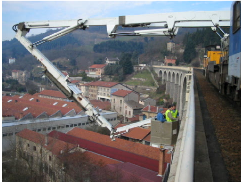
FIGURE 1.2 – Exemple d’inspection des ouvrages d’art (source internet)
