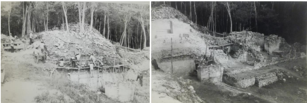
Fig. IV-5. Dégagement et consolidation autour de la structure V-B à Becán (Bueno et Gutierrez, 1985).
