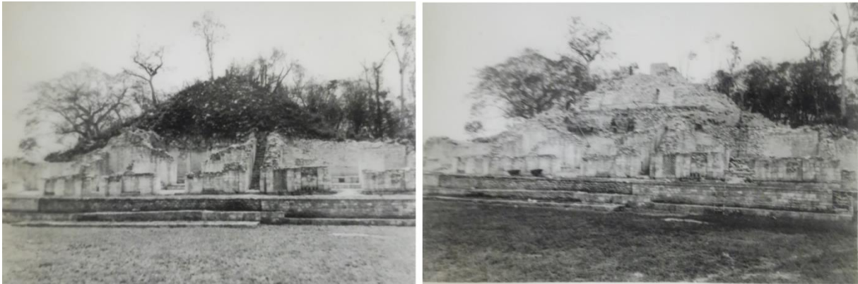
Fig. IV-4. Structure II de Becán après les opérations de Bueno (Bueno et Gutierrez, 1985).
