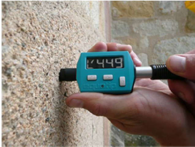
Figura 7: Durómetro utilizado para probar la resistencia mecánica de los materiales, aquí en una iglesia medieval de Malicorne (Francia).
