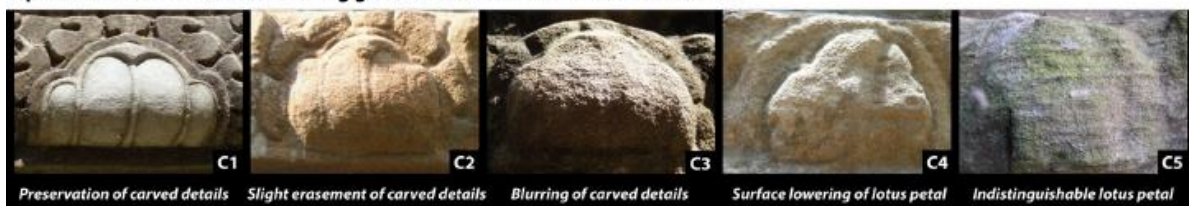
Fig. I-14. Echelles visuelles de détérioration mécanique et biochimique des pétales de lotus de Ta Keo à Angkor, Cambodge (André et al. , 2012b).
