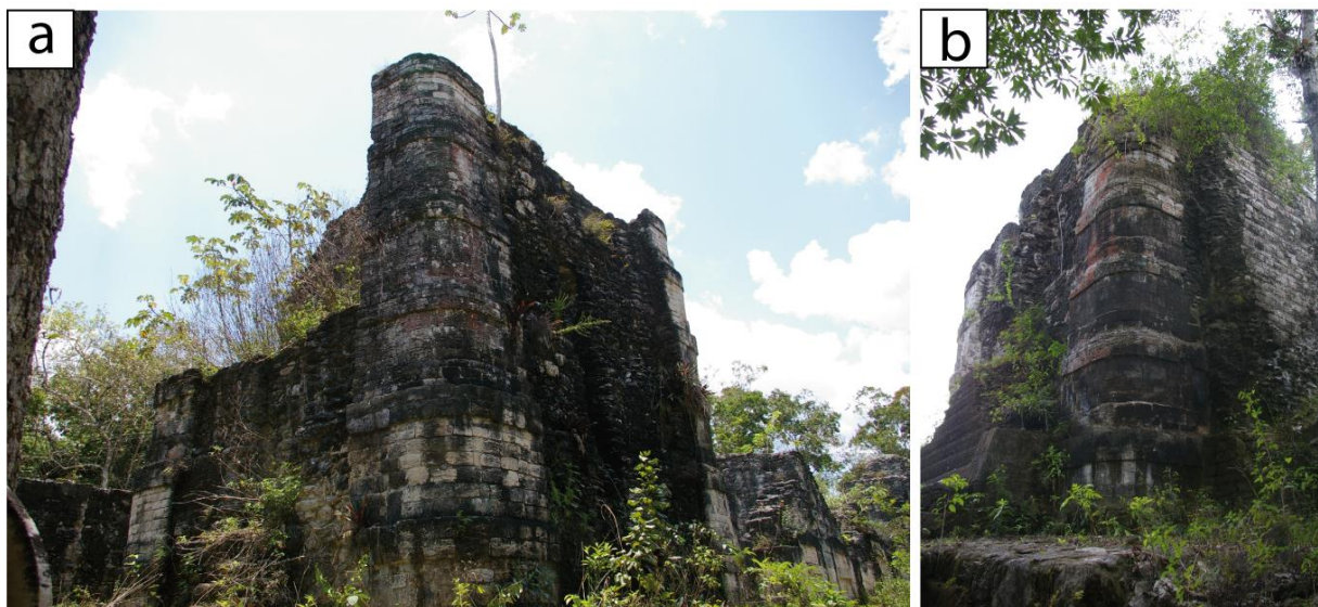
Fig. VI-9. Les tours nord-est (a) et nord-ouest (b) de la structure 5N2 à Río Bec.
