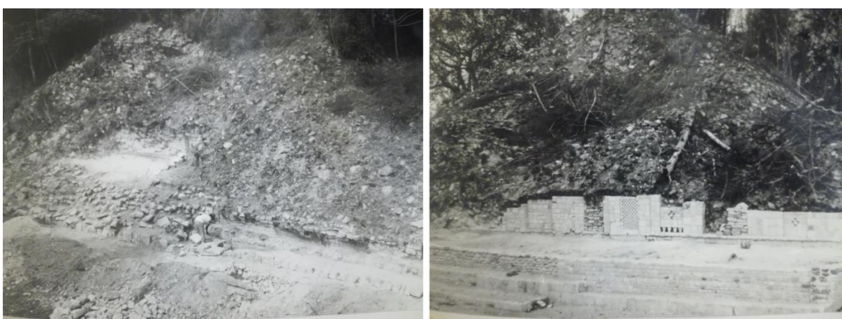
Fig. IV-3. Structure II de Becán au début des travaux de dégagement (à gauche), et panneaux à damiers après leur reconstruction (à droite) (Piña Chan, 1983).
