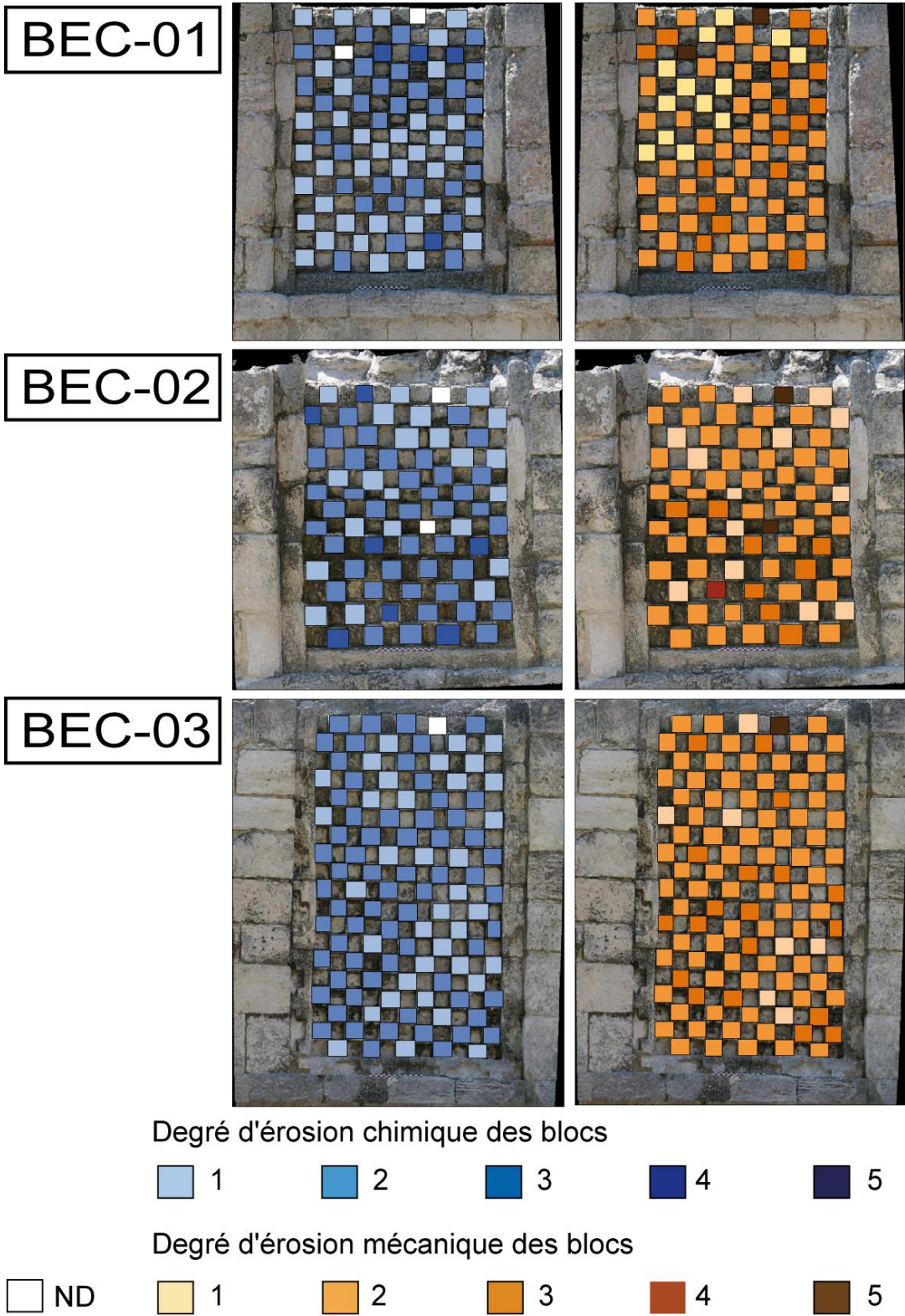
Fig. VI-28. Spatialisation des degrés d'érosion chimique et mécanique sur les panneaux à damiers de la structure II de Becán.
