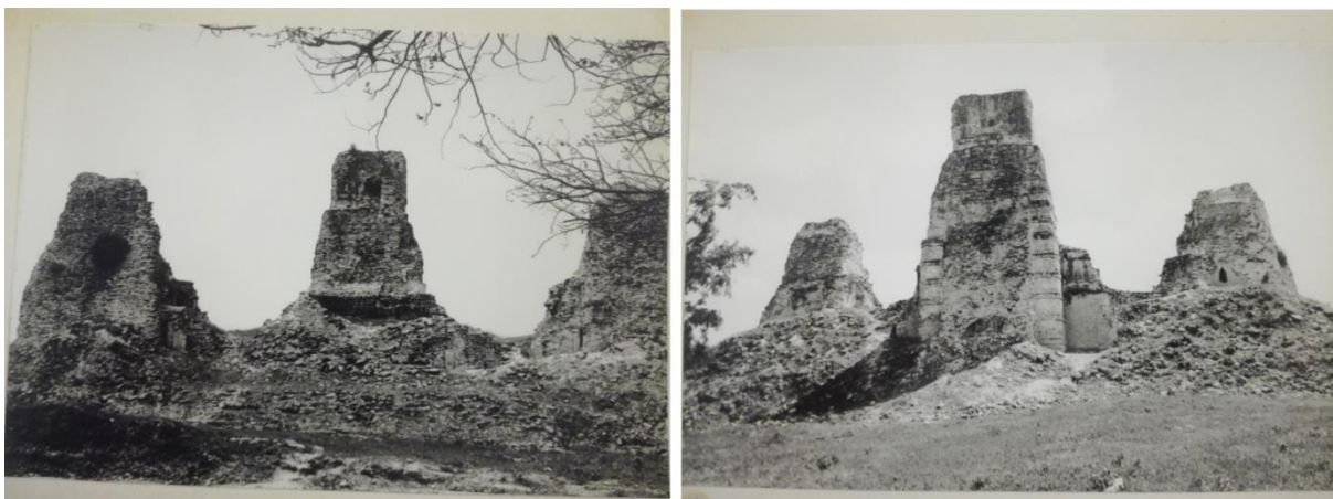
Fig. IV-10. Clichés des façades est (à gauche) et ouest (à droite) de la structure I de Xpuhil avant les travaux de 1982 (Piña Chan et Landa, 1983).
