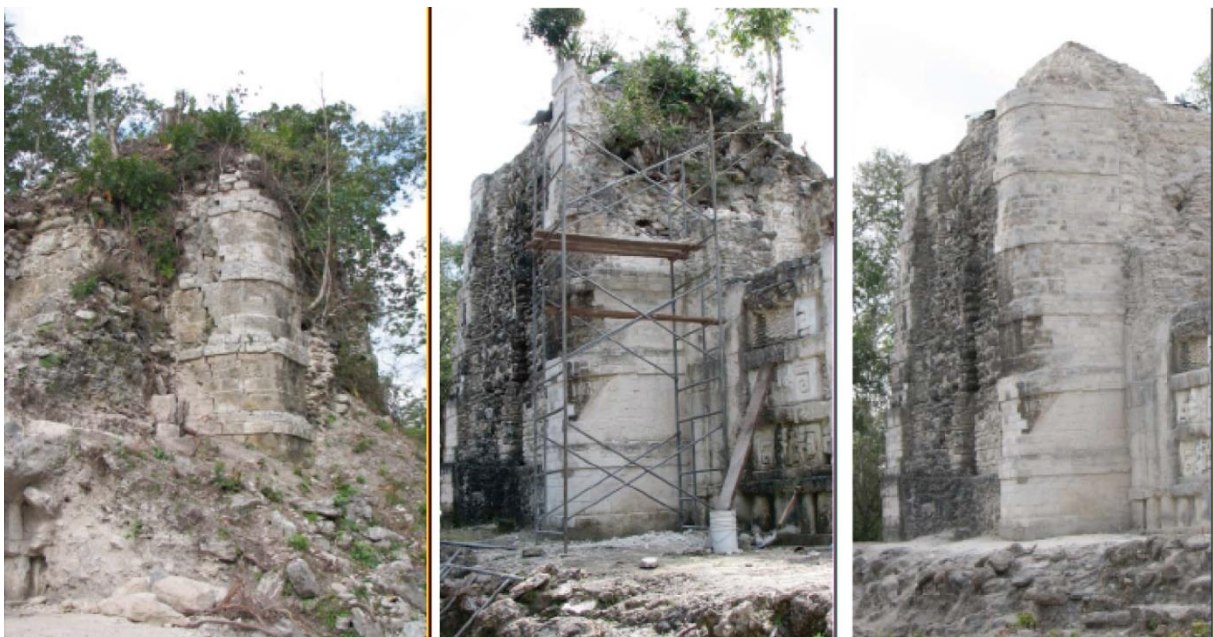
Fig. IV-16. Clichés de la tour nord-est de 5N2 avant (à gauche), pendant (au centre), et après (à droite) les opérations de la cinquième saison du Projet Río Bec en 2006 (Michelet et al. , 2007).
