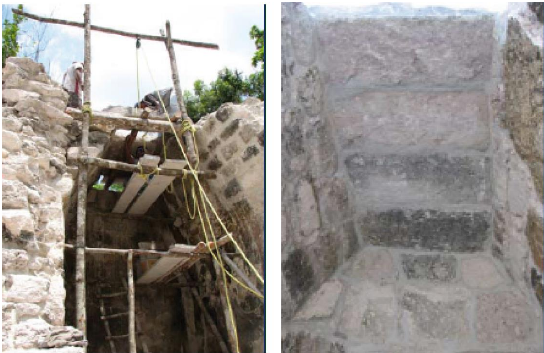
Fig. IV-19. Restitution des voûtes sur les chambres de 5N2 en 2007 (Michelet et al. , 2008).
