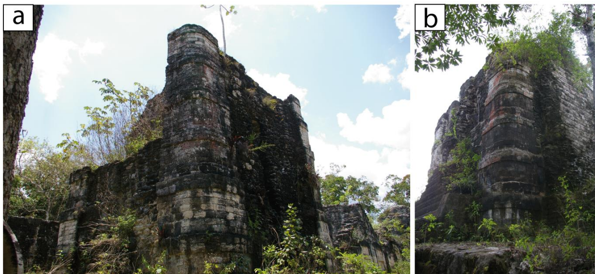
Fig. VI-9. Les tours nord-est (a) et nord-ouest (b) de la structure 5N2 à Río Bec.
