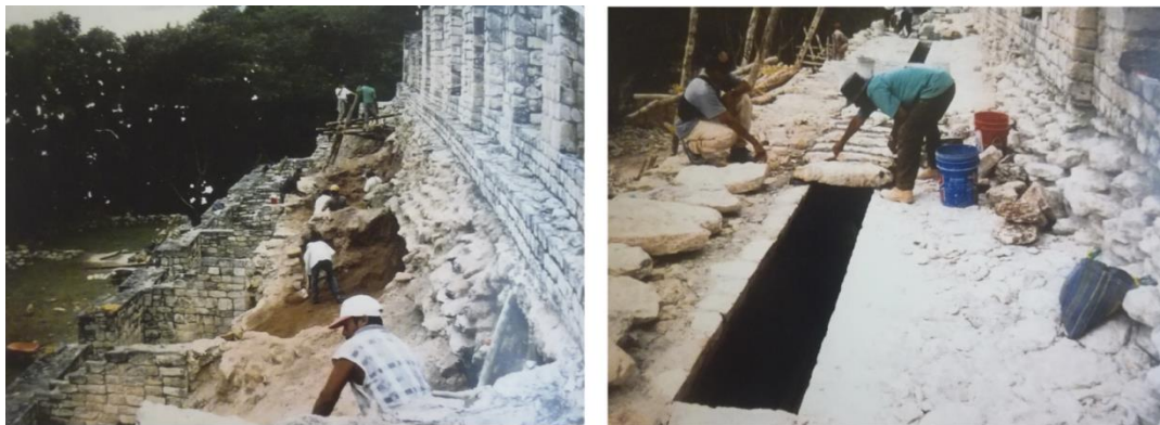
Fig. IV-6. Construction en cours (à gauche) et finalisée (à droite) de la terrasse d'accès au niveau supérieur de la structure I (Campaña Valenzuela et al. , 2004).
