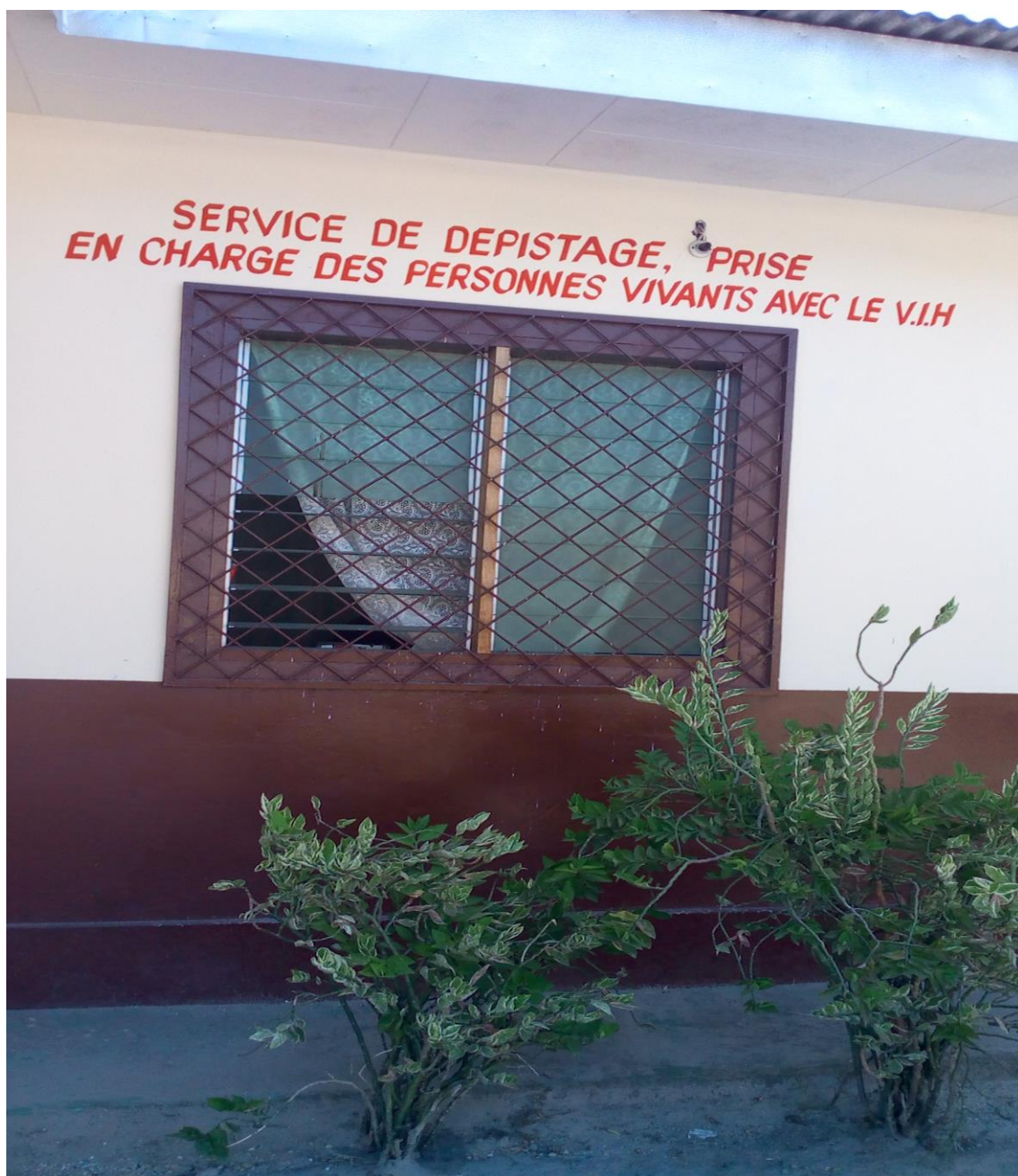
Photo 7 : Façade latérale du centre de prise en charge évangélique de M'paka (Pointe-Noire)
