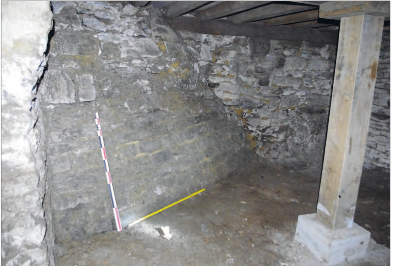
Fig. 162 : Front taluté de la porte aux Foulons au second niveau de caves du 3, rue de la Motte Fablet
