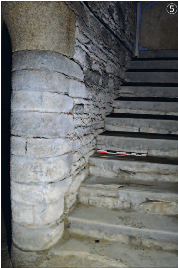
Fig. 201 : Escalier reliant le niveau -1 au niveau intermédiaire
