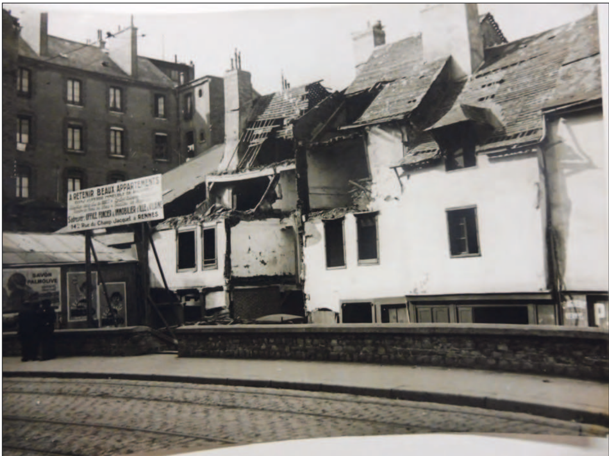
Fig. 127 : Destruction des maisons de la partie septentrionale de la rue du Champ-Dolent, photographie anonyme, octobre 1934, MB 956.0002.529
