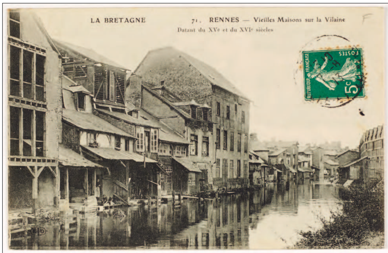
Fig. 121 : Rennes, vieilles maisons sur la Vilaine, datant du XV e et du XVI e siècles, carte postale, éditions Ernest Le Deley, début du XX e siècle, MB 995.0008.1070. Le cliché a été réalisé en amont des moulins de Saint-Héliier. La mise en œuvre des pièces de bois, les matériaux de construction et les dimensions de certaines maisons renvoient à un bâti bien postérieur à l'époque médiévale
