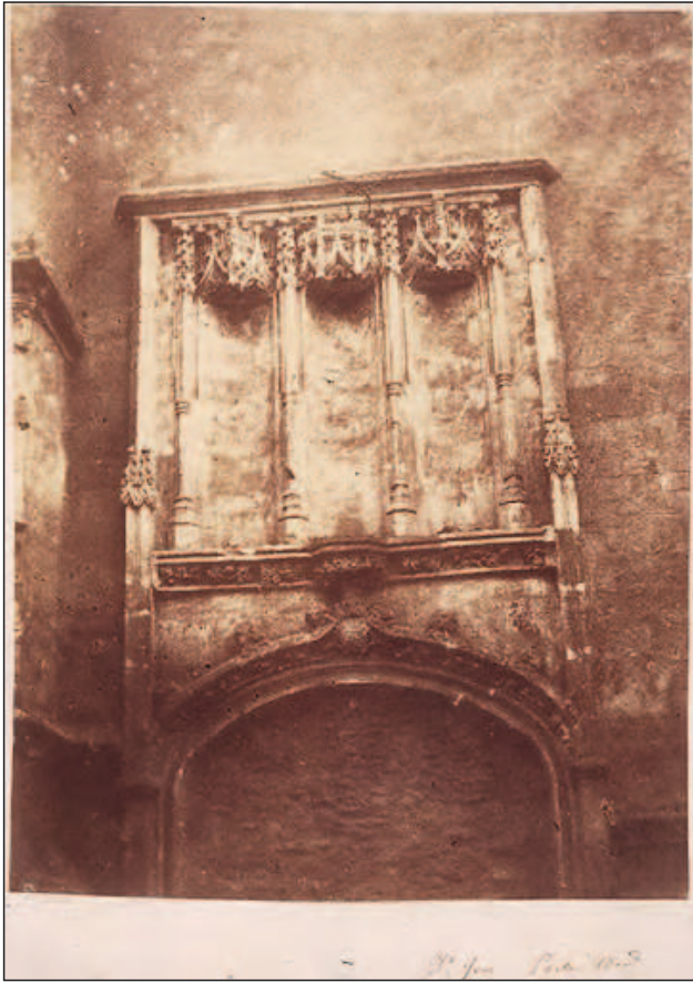
Fig.14 : Porte nord de l'hôpital Saint-Yves, photographie de Th. Goupil, 1858, MB 949.1814.1.7
