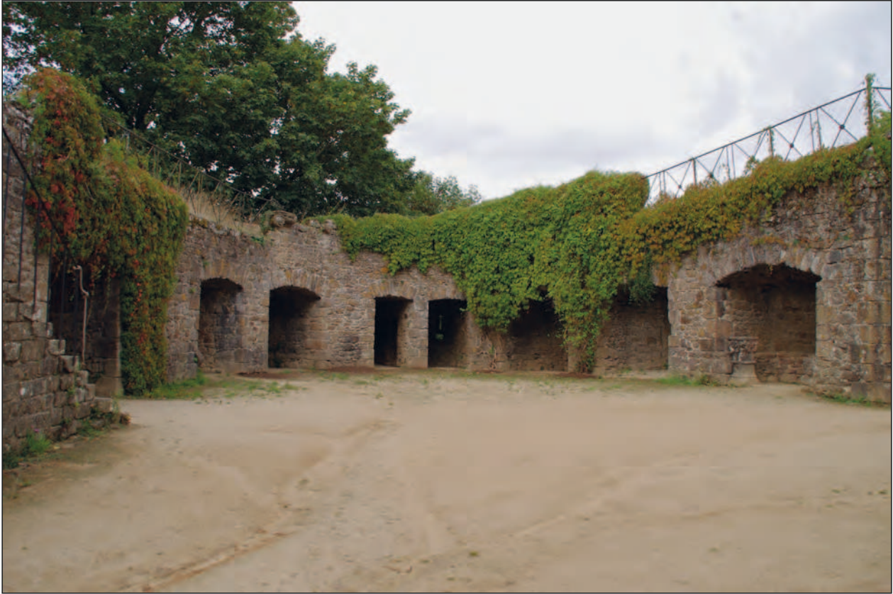
Fig. 204 : Niveau intermédiaire du boulevard du château de Lassay (53)
