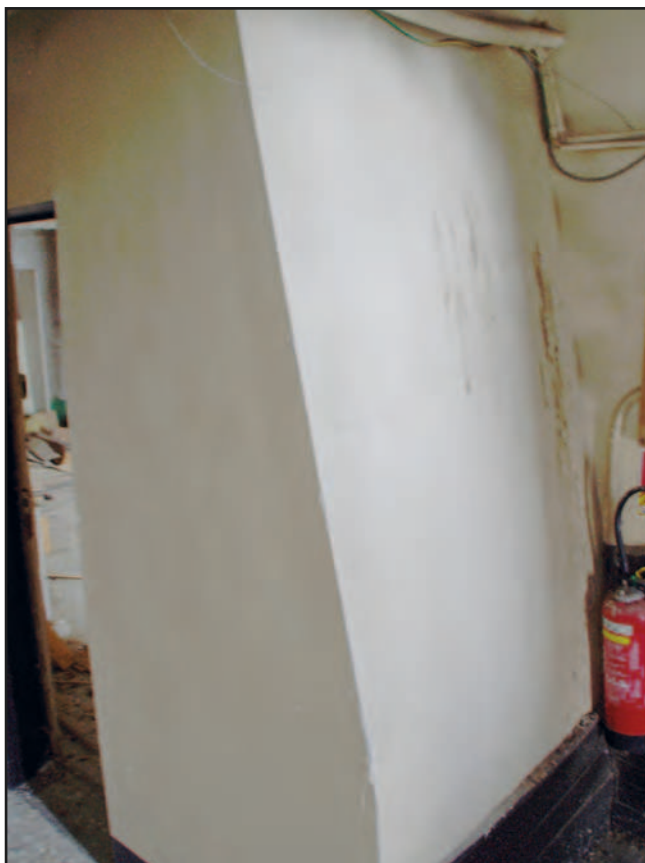
Fig. 286 : Ancienne pente de toit au troisième étage
