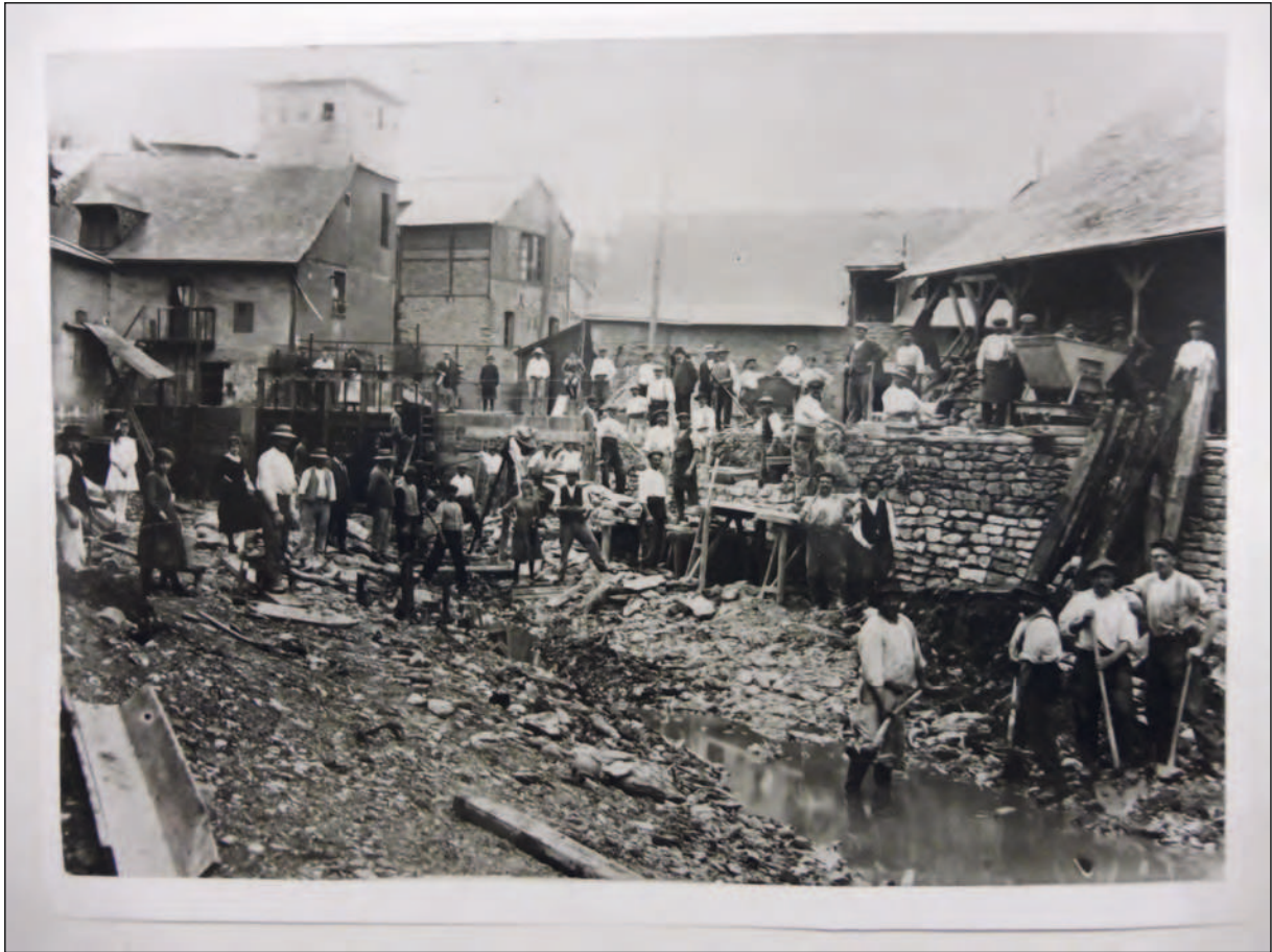
Fig. 82 : Travaux de maçonnerie en amont des moulins du Bourg l'Évêque, première moitié du XXe siècle, musée de Bretagne, n° 976.0011.2
