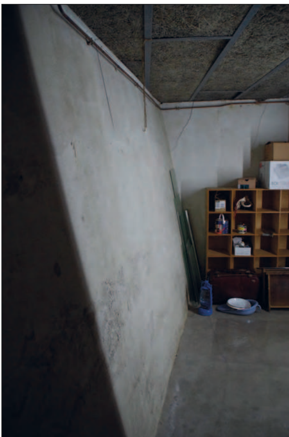
Fig. 185 : Talus du boulevard de la porte aux Foulons avant piquetage dans les caves du n°6
