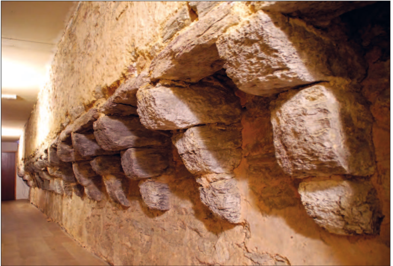
Fig. 156 : Mâchicoulis soutenus par des corbeaux en schiste à trois ressauts conservés au premier étage du 15, place du Champ-Jacquet
