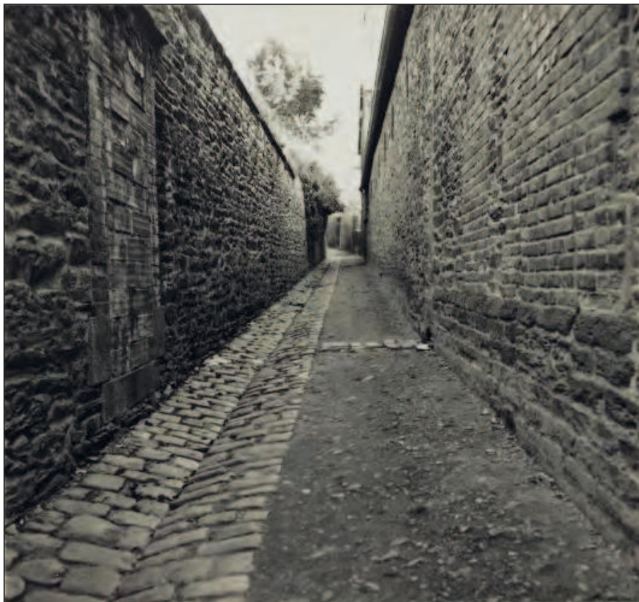
Fig. 306 : Partie basse de la ruelle aux chevaux, MB 975.0083.8
