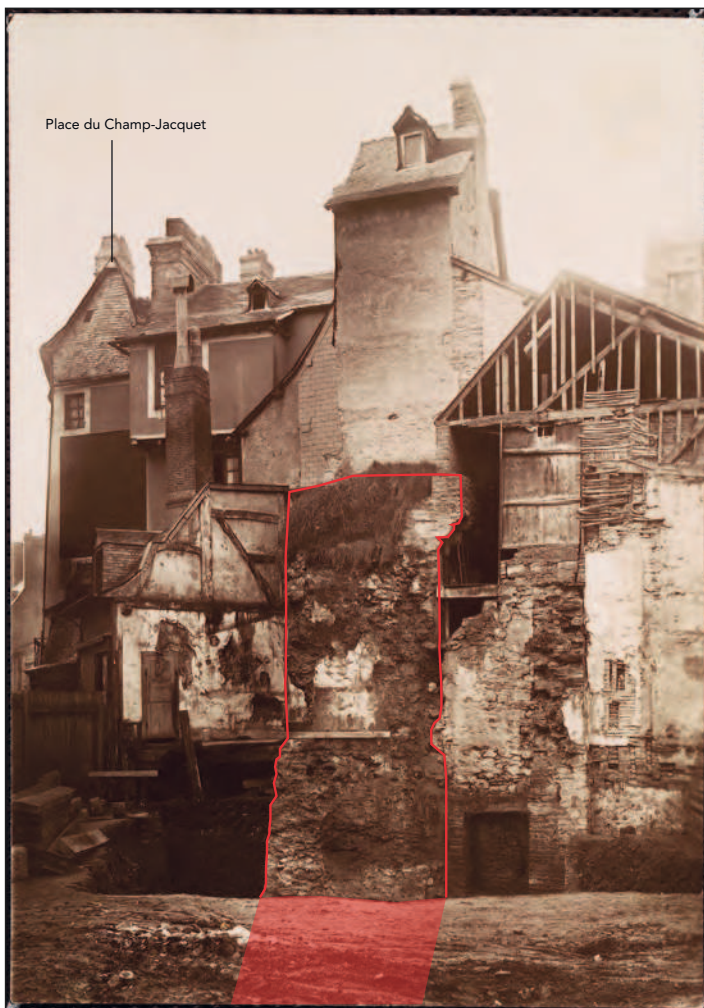
Fig. 158 : Écorché d'une section de courtine de l'enceinte de la Ville Neuve (en rouge) au niveau du 25, rue du Champ-Jacquet, photographie anonyme, vers 1911, MB 911.0011.1
