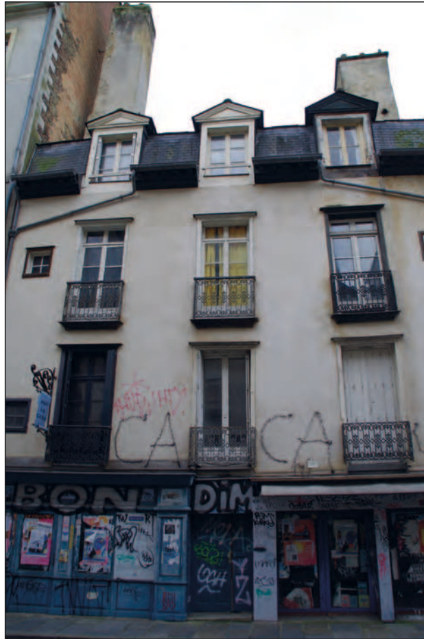
Fig. 281 : Façade sur rue de l'immeuble à pan-de-bois du 6, rue Capitaine Dreyfus
