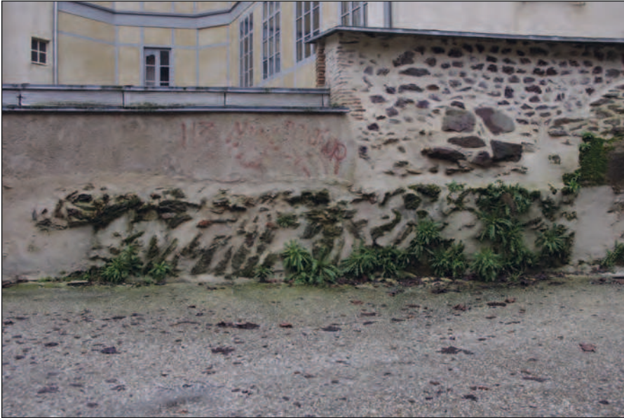
Fig. 180 : Vestiges de l'enceinte antique au 11, rue des Dames, vue générale
