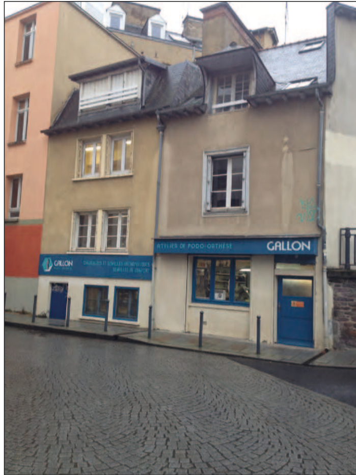
Fig. 297 : Les deux dernières boucheries de la rue du Champ-Dolent
