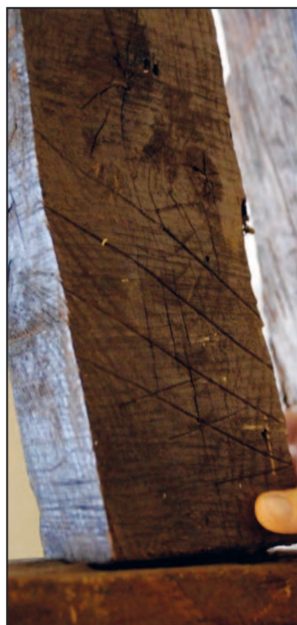
Fig. 289 : Marque d'assemblage au deuxième étage
