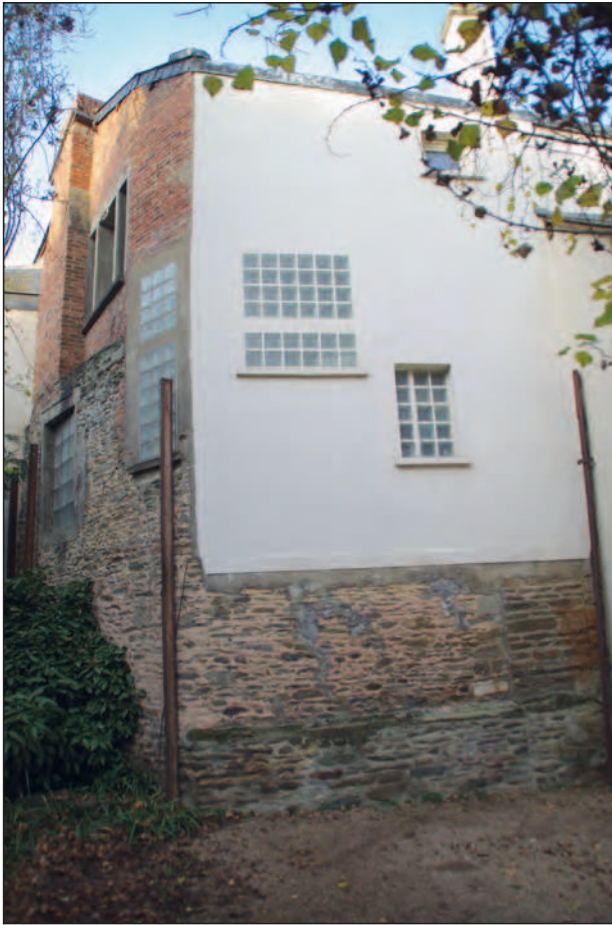
Fig. 148 : Mur de circonvallation de la prison de la tour le Bât érigé au XVIIIe siècle (5, Contour de la Motte, parcelle BE 351)
