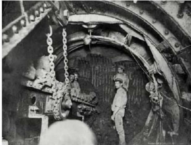
*Figure I-2 : Tunnel revêtu d'un anneau de voussoirs, en acier circulaire et boulonné creusé par J. H. Greathead [I-1].*
