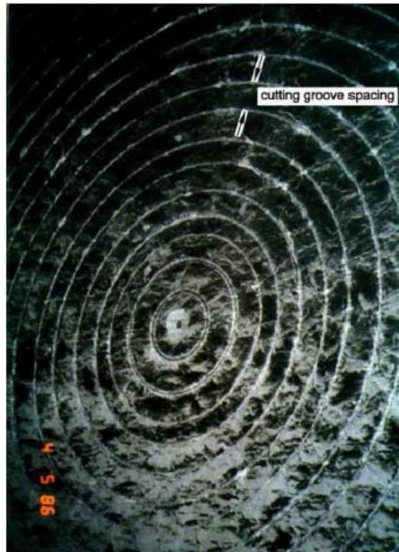
Figure I-5 : Traces laissées par les disques à molette sur le front de taille [I-5].
