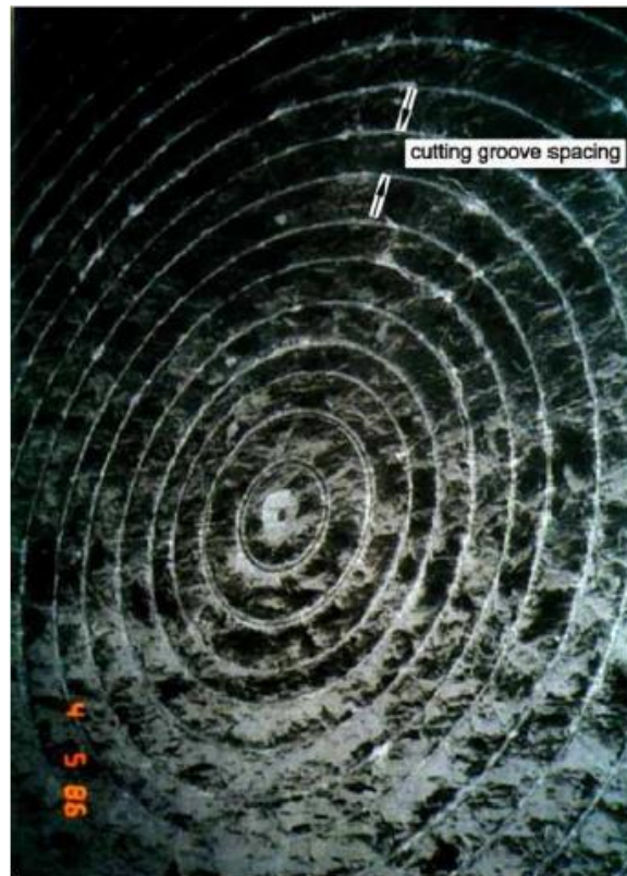
Figure I-5 : Traces laissées par les disques à molette sur le front de taille [I-5].
