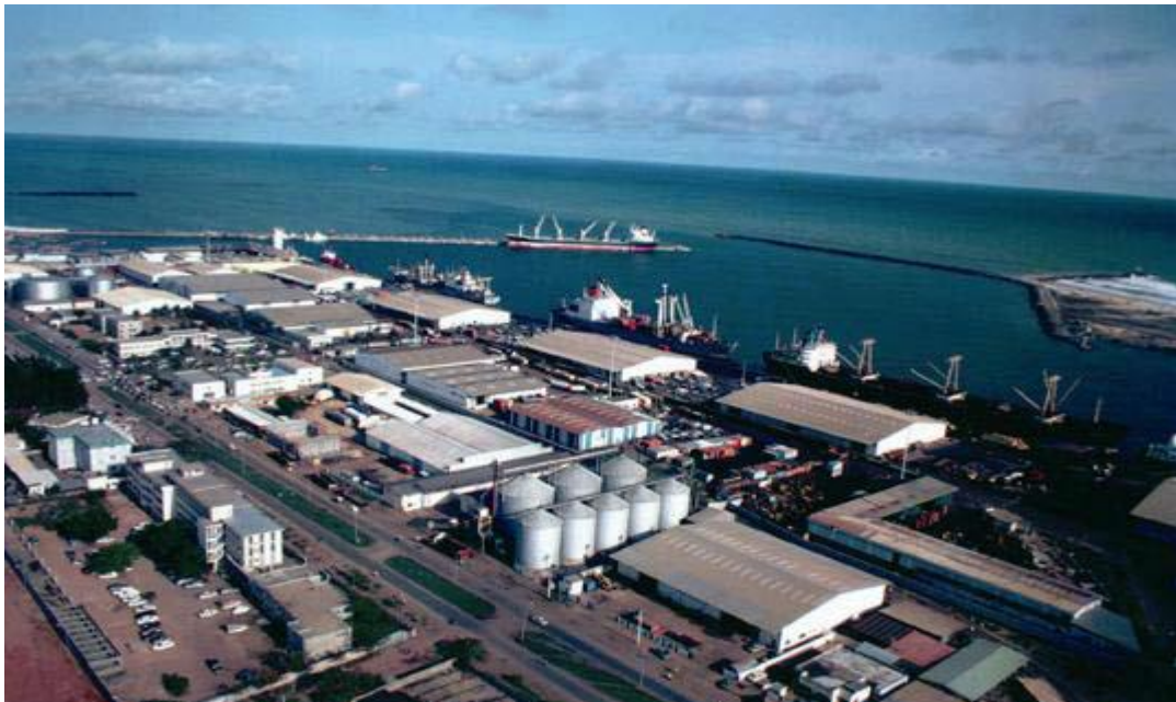
Figure N°3 : Vue Partielle des Installations du Port Autonome de Cotonou
