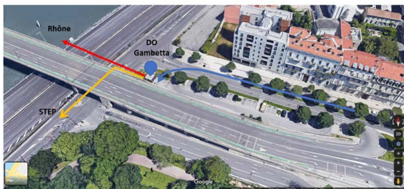
Figure A.2 – Vue en 3D de la localisation du DO « Gambetta ». Les débits d'entrée, déversé et conservé correspondent aux flèches bleue, rouge et jaune, respectivement.
