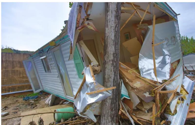
Figure 79 : Dégâts occasionnés dans l'un des campings suite aux inondations meurtrières du 3 octobre 2015 dans les Alpes-Maritimes (Source Nice-Matin)
