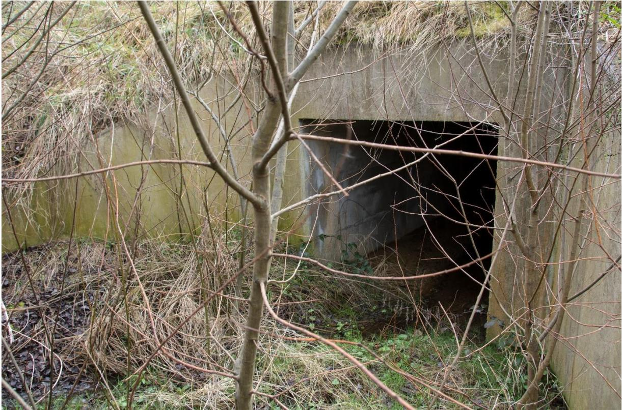
Ouvrage hydraulique à Beaulieu-sur-oudon (Mayenne) 1.5 x1.5 m pouvant être utilisé par les amphibiens lors de mouvements de migration ou dispersion
