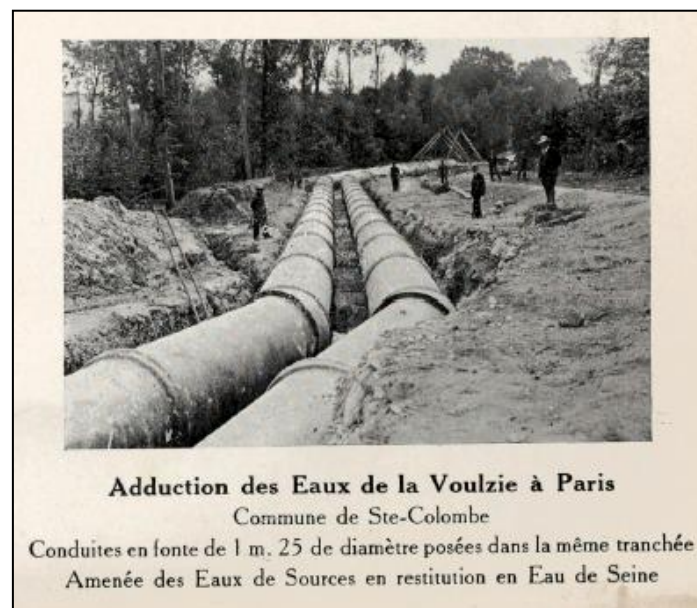
Figure 5.14 - Conduites parallèle de dérivation des sources de la Voulzie et de restitution des débits dérivés en eau de Seine. Source : Lemarchand, 1923 ; Gallica/BnF. Dates de la photo non précisée. Luminosité et contrastes retouchés.
