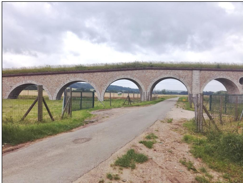
Figure 6.3 – Siphon de l’Eure (aqueduc de l’Avre) végétalisé. Photo : M. Resch, 2018.
