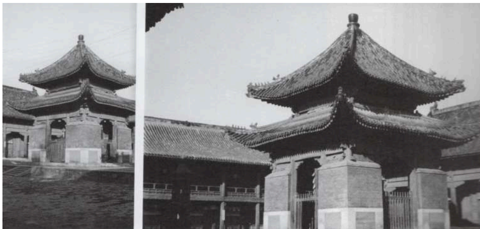
Figure 4-7 : Le pavillon abritant la stèle impériale du Yonghegong.
