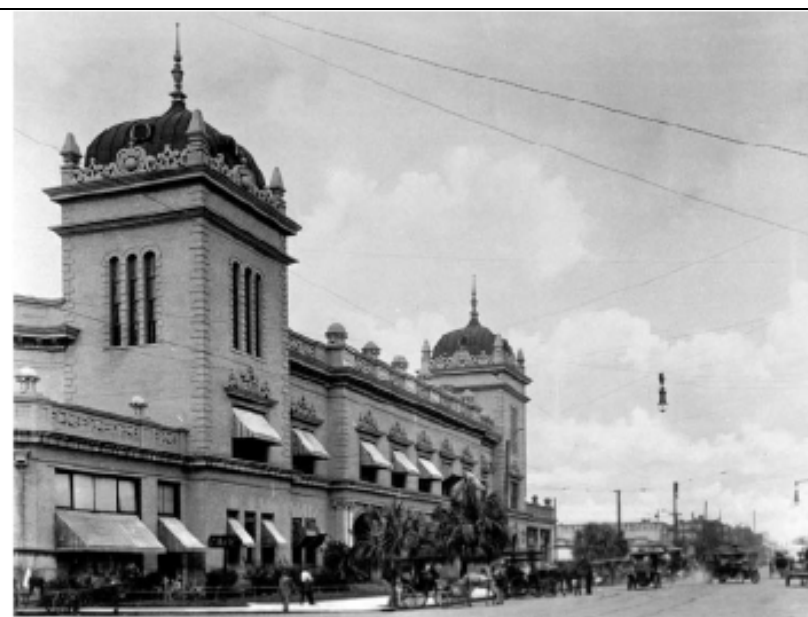
Figure III-11 : Vue du bâtiment de la Union Station. Une gare qui reliait Savannah au reste des États Unis.
