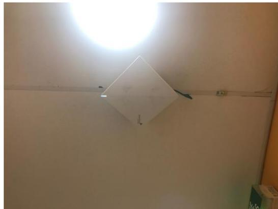
Fig. 4.19. Routeur Wi-Fi modèle AP 120 de Aerohive installé au plafond du couloir.
